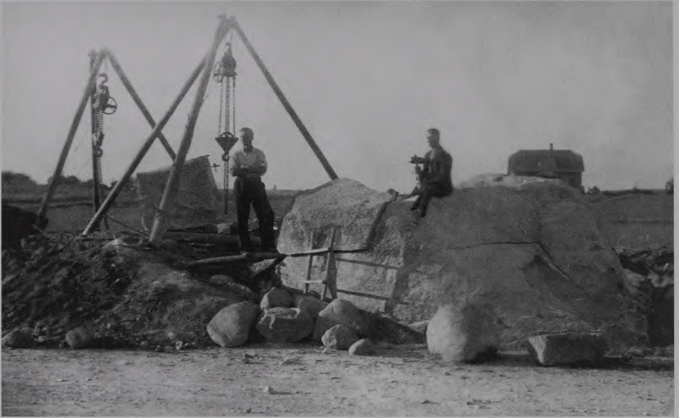
67. att. Daļēji sadalītais Rembates Ārņa akmens un trijkāji ar trišiem akmens daļu pārvietošanai 1939. gada vasarā. Akmeņkaļi J. Dambekalns un J. Blumbergs.
