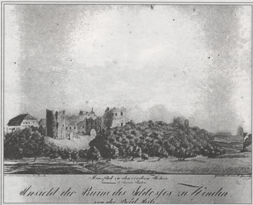
64. attēls. Mērnieku V. Tuša un Hr. Kunces zīmētais Cēsu jaunās pils, pilsdrupu un Riekstkalna skats no 1827. g. no ziemeļu puses. Oriģināls Pauluči albūmā ZA Fundamentālajā bibliotēkā, reto grāmatu un rokrakstu sektorā. KPRPK fotoneģatīva Nr. 33371.
