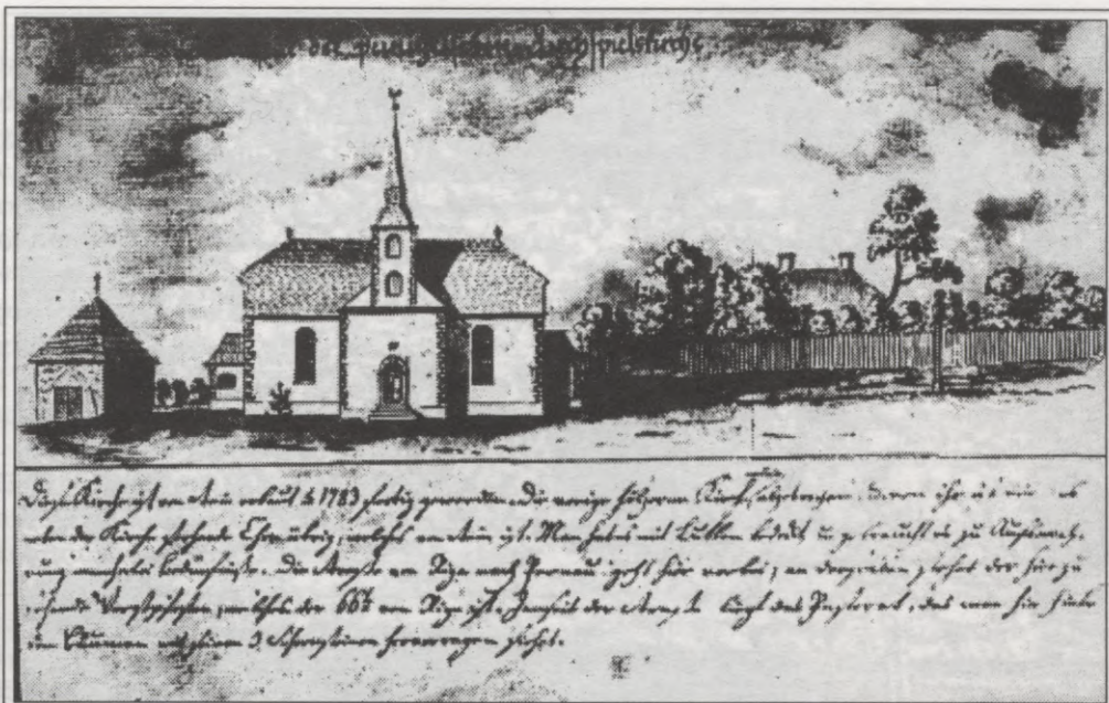
22. att. Vecās Liepupes baznīcas altārdaļa pēc draudzes telpas nojaukšanas. J. K. Broces 1817. g. zīmējums. (Skat. atsevišķi stāvošo taisnstūrveida būvi no jaunās baznīcas pa kreisi.)
