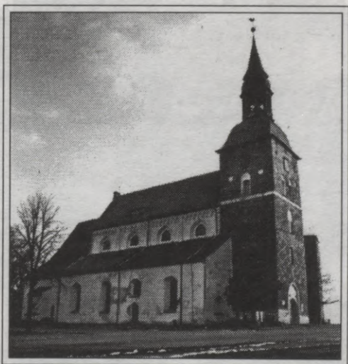
58. att. Valmiera. Sv. Sīmaņa baznīca. 1988. g.
