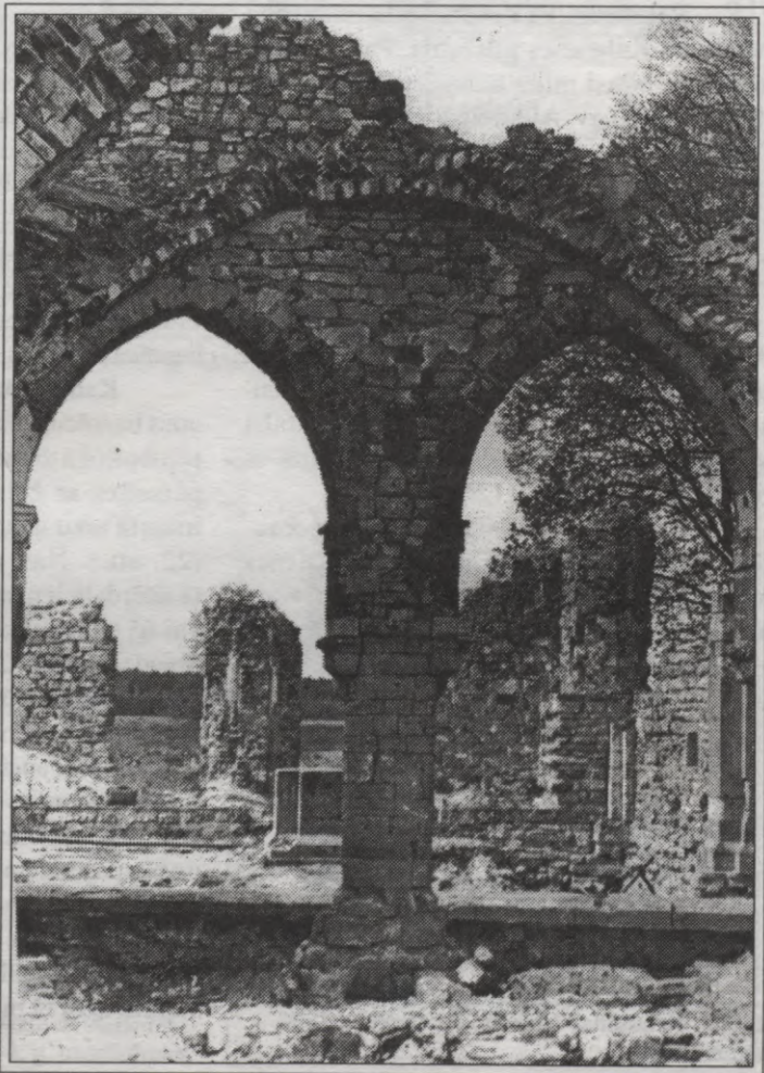
19. att. Ikšķīle. II baznīca. "Gotlandiskais" balsta stabs. 1974. g. foto.
