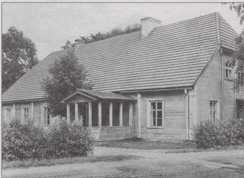
Talsu mācītājmāja (18. gs. beigas). Foto 1990. Kopā ar klēti un citām ēkām veido ainaviski izteiksmīgu ansambli
