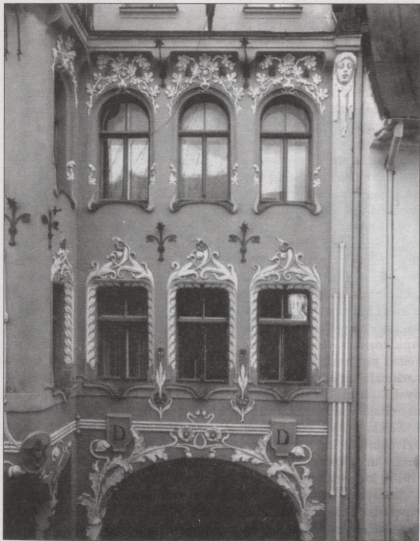
Ēka Rīgā, Šķūņu ielā 12/14. 1902. gads. H. Šēls, F. Šefels. Fasādes fragments
