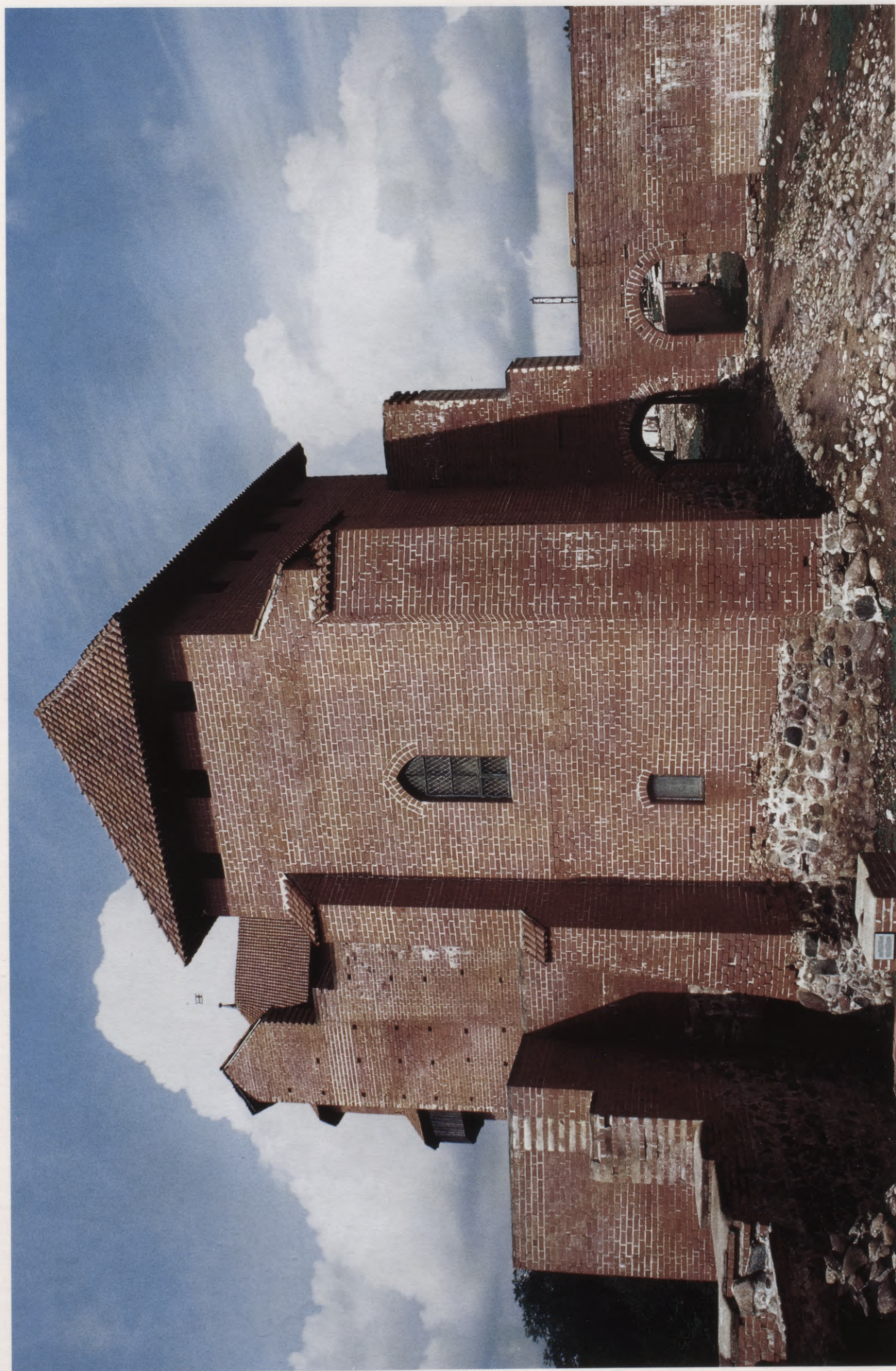
6.att. Dienvidu korpuss pēc restaurācijas no D.
