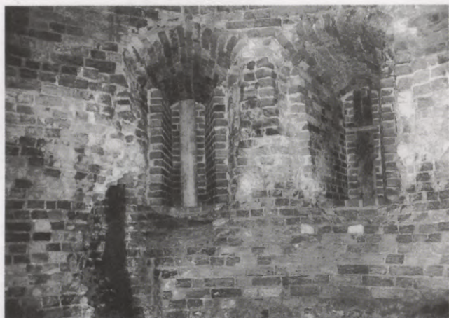
44. att. Šaujamlūkas pusapaļā torņa pirmajā stāvā dienvidrietumu daļā (šaušanai gar R sienu uz dienvidiem).
