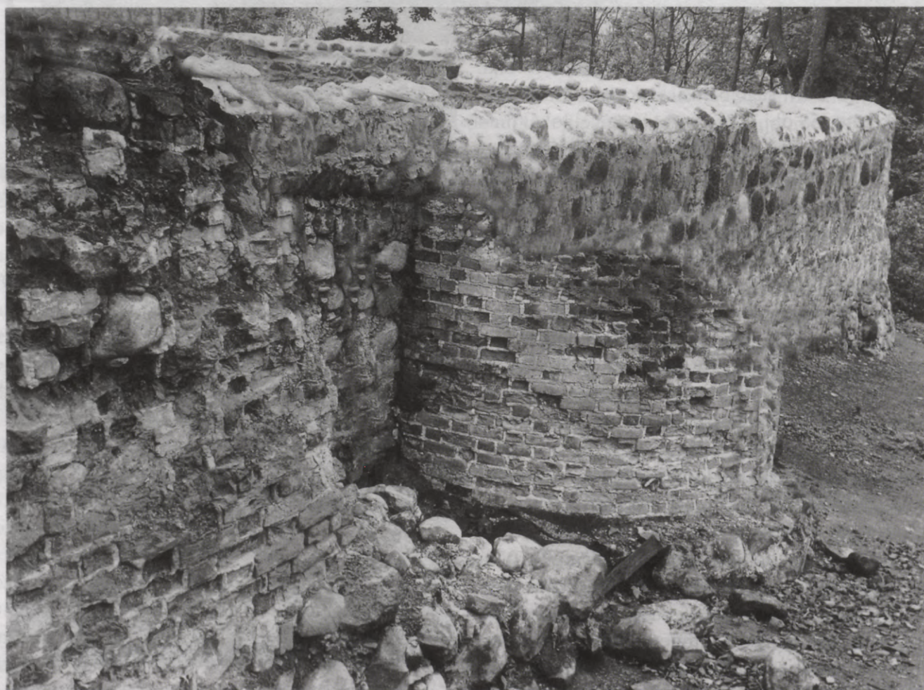
112. att. Mazais tornītis dienvidu priekšpils R aizsargmūra ārpusē no ZR.
