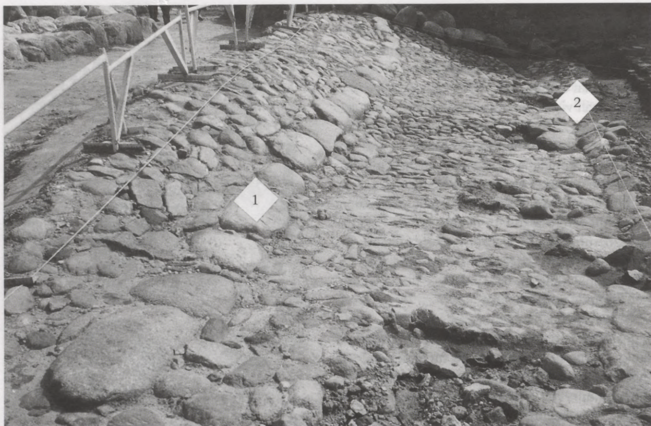
93. att. Pils iebraucamā ceļa augšdaļā R malā atsegtais senākā ceļa bruģējums no Z: 1 – lielu akmeņu rinda, 2 – ūdens noteka.
