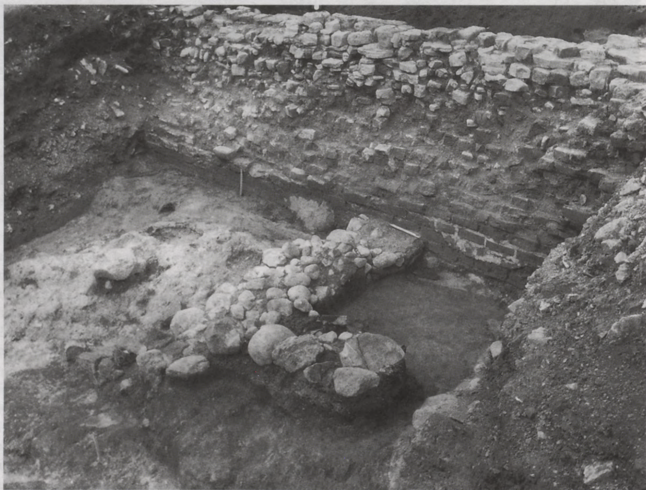
127. att. Celtnes pamatu fragments Z–I laukuma ziemeļrietumu daļā no Z, uz gaišas pamatzemes. 0,80 m biezie pamati celti no galvas lieluma un lielākiem laukakmeņiem, bez saistības ar kādu citu celtni.
