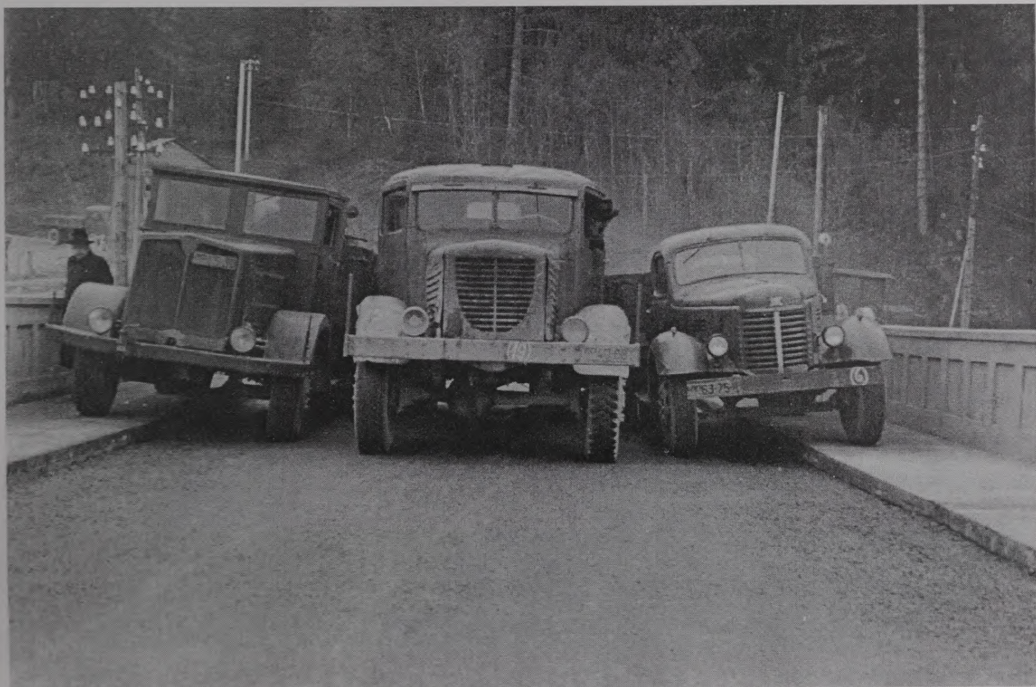
38. attēls. Tilta statiskā un dinamiskā pārbaude 1950. gada aprīlī.
