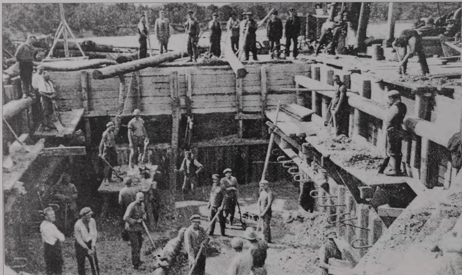
22. attēls. Kreisā krasta balsta būvbedres rakšana.
