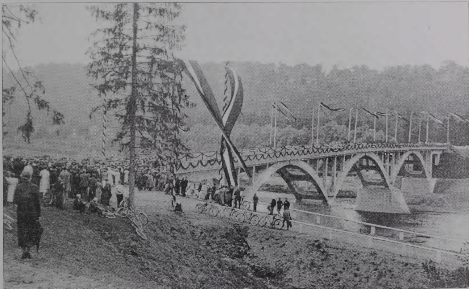
1. attēls. 1937. gada 23. jūlijs. Tilta pār Gauju atklāšana.
