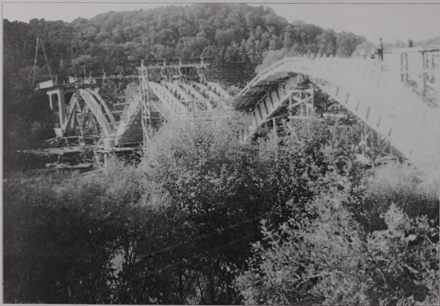
34. attēls. Tiltā loku turu kopskats.
