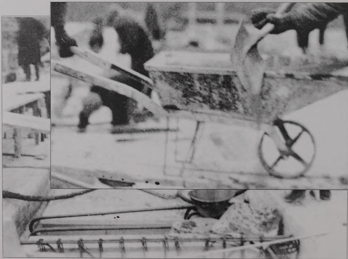
24. attēls. Filta brauktuves betonēšana.
