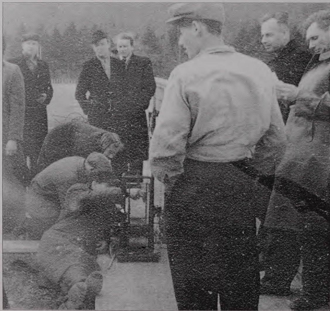
39. attēls. Tīlta dinamiskā pārbaude, kurā izmanto Geigera vibrogrāfu.
