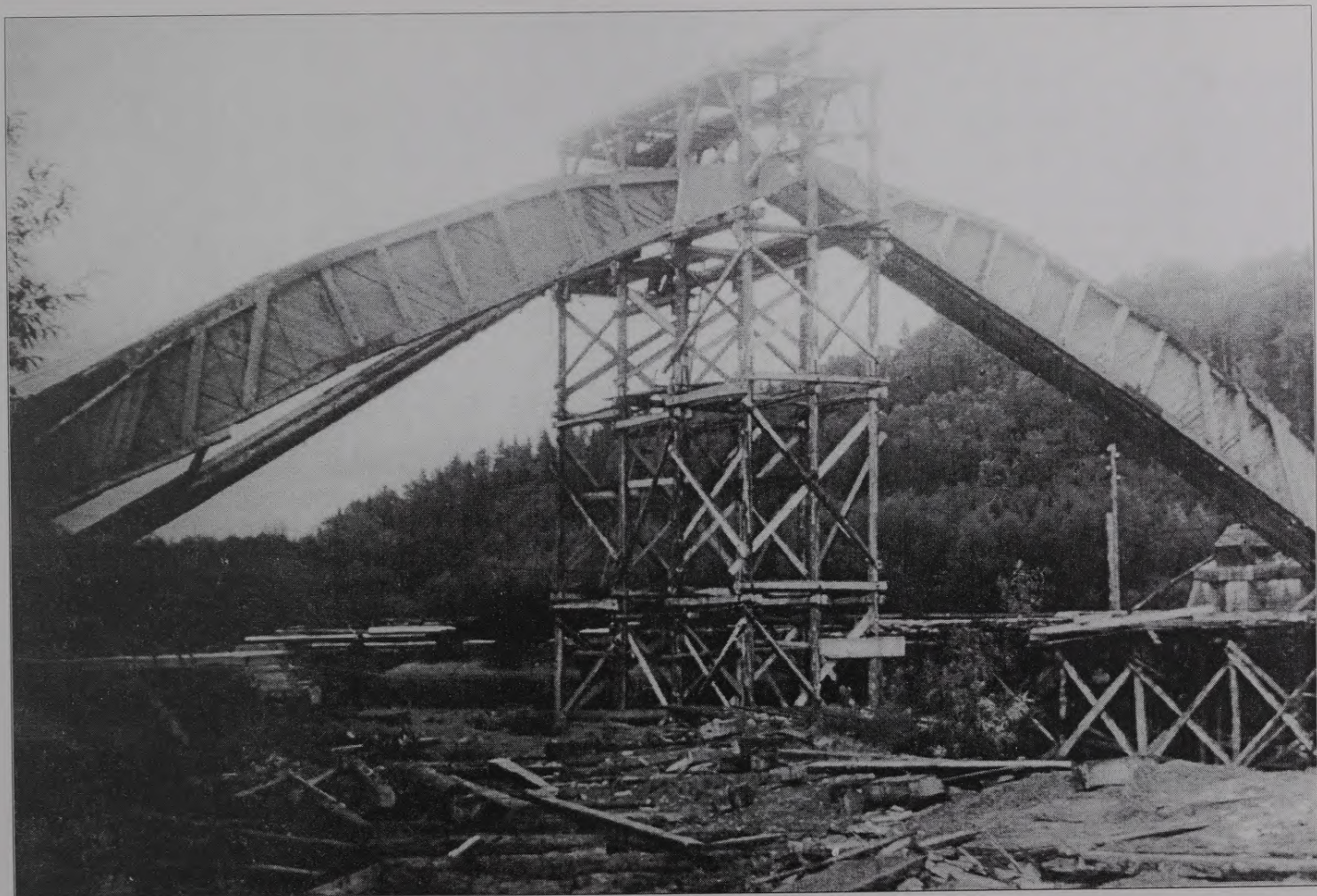
33. attēls Loku turu un segmentveida kopņu pacelšana
