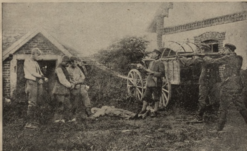
Bermontieši šauj latviešus.
