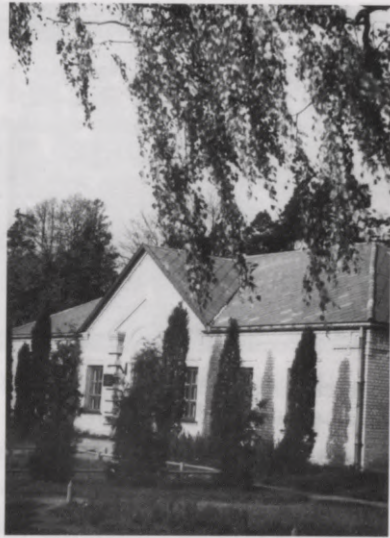
Administratīvā ēka Ropažu MTS – Rīgas MTS, 1954. gads.
