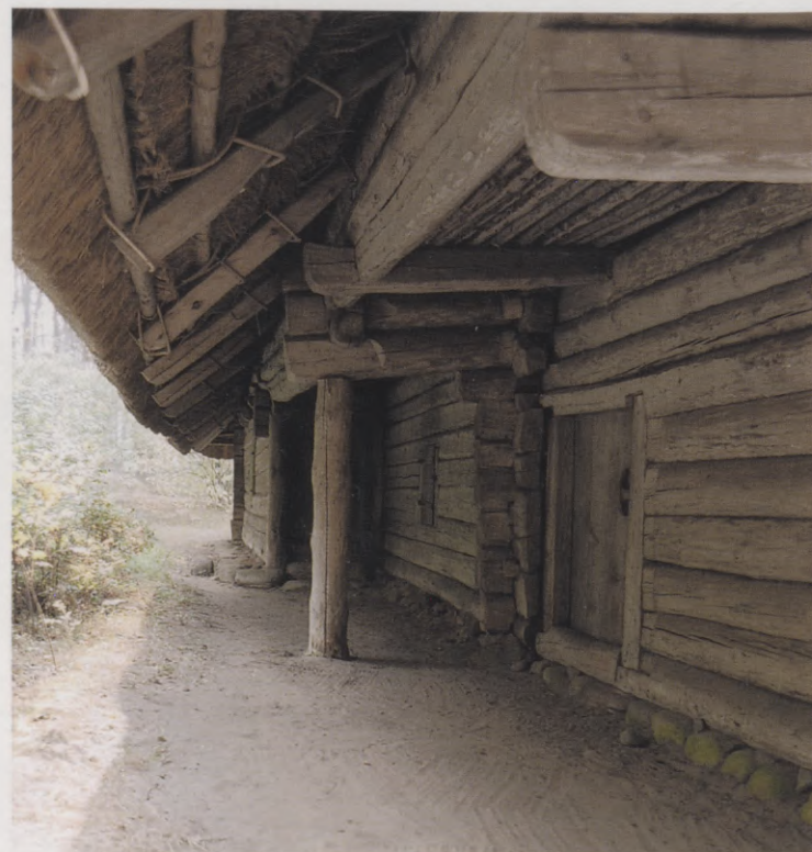
Augšējo baļķu izlaidums (konsole) ▼
