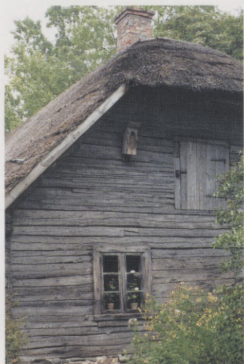
▲ Vertikālais logs ar rūtojumu un virām vienai vērtnei
