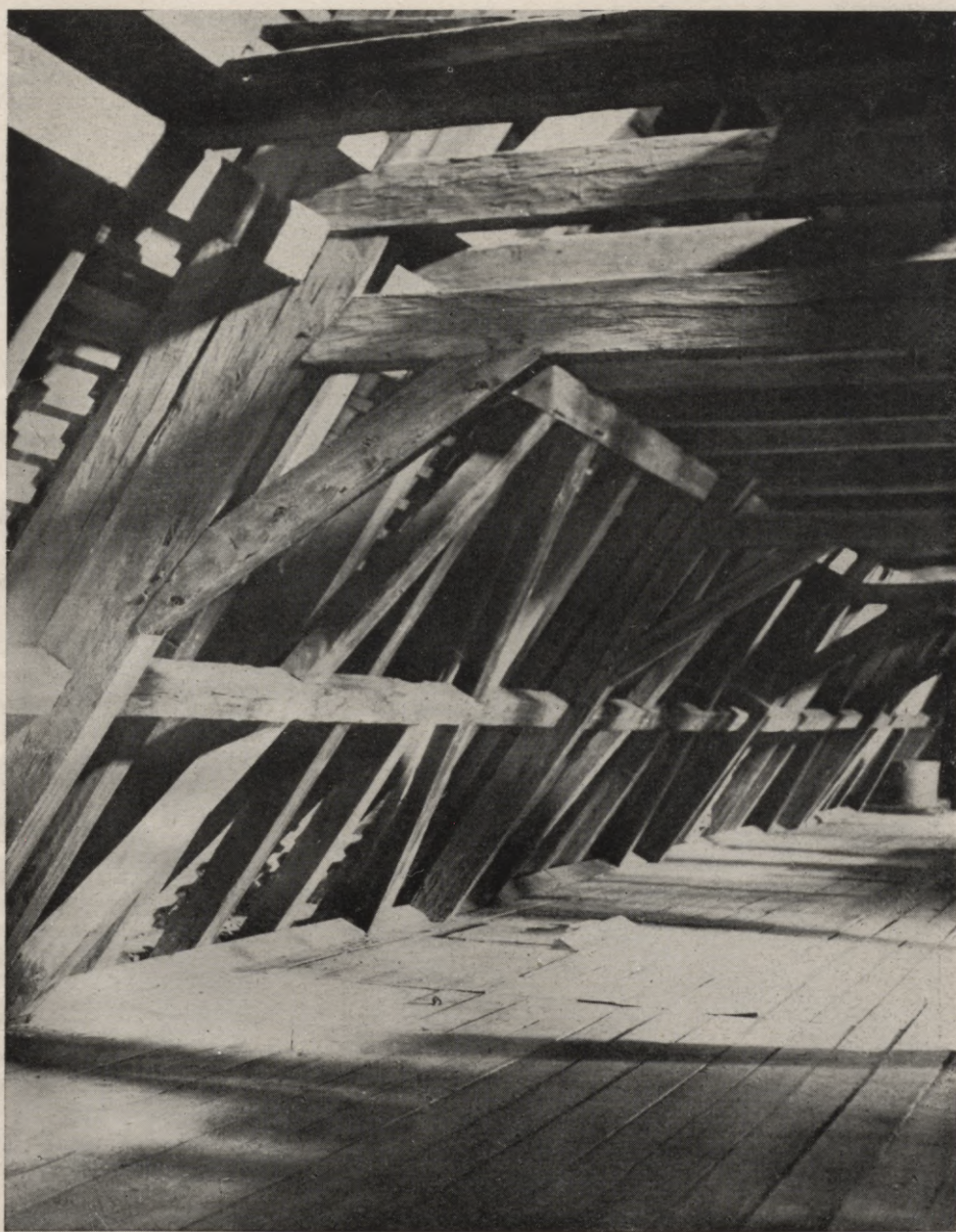
32. att. Baznīcas jumta konstrukcija.
