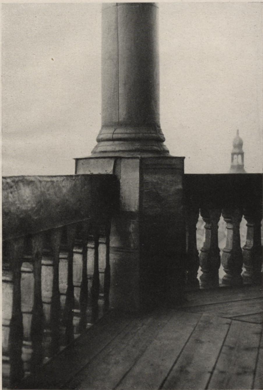
5. att. Torņa pirmās galerijas kolonnas pamatne un balustrāde.
