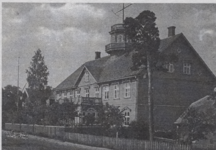
6. att. Ainažu jūrskolas ēka, 20. gs. sākums. Ēka būvēta 1902. gadā. II pasaules kara laikā nodegusi.
