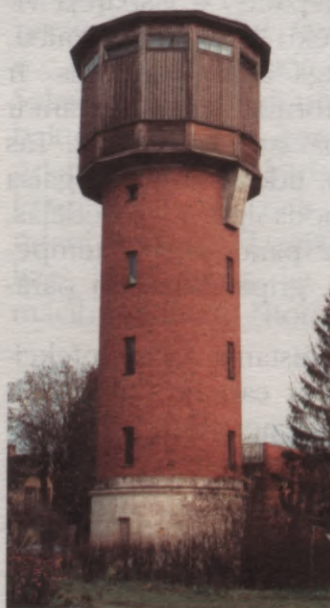
Lakstīgalas ielas ūdestornis ▶
