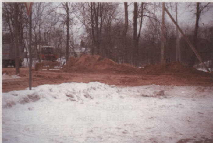
Spiedvada būvniecība Šveices ielā
