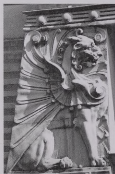
29. A. Ļebedinska nams Alberta ielā 4. Fasādes dekora fragments
