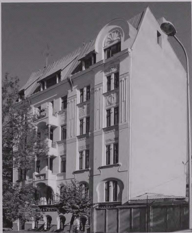
26. E. Fišera nams Strēlnieku ielā 6
