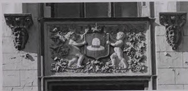
23. Paulīnes Birkas nams Tērbatas ielā 7. Fasādes dekora fragments
