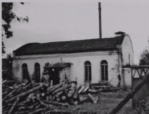
4. Grīva (Daugavpils). Bijusī sinagoga (tagad pirts) Sēlijas ielā 18
