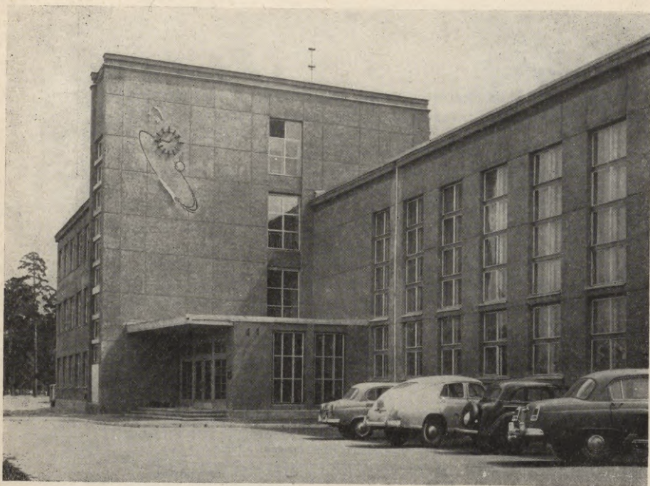
LPSR ZA Celtniecības un arhitektūras institūta ēka. Arhitekts G. Mincs
