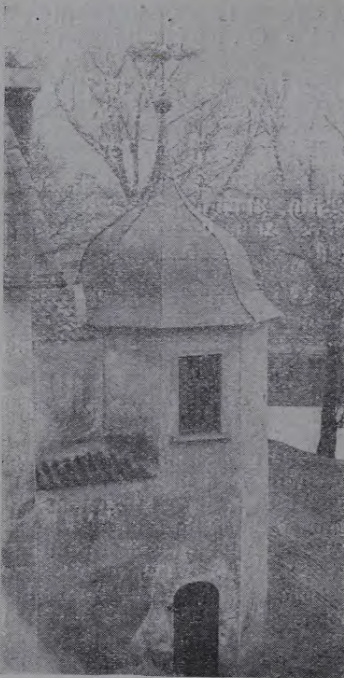
Schloss Neuenburg (Kurland) Wachturm
