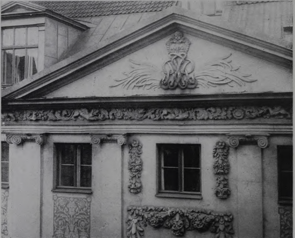
Abb. 27. Giebel des Ratsherrn Joh. v. Reutern'schen Hauses, Riga, Marstallstraße Nr. 2. Lichtbild des Stud. A. Dogadkin, 1939.
