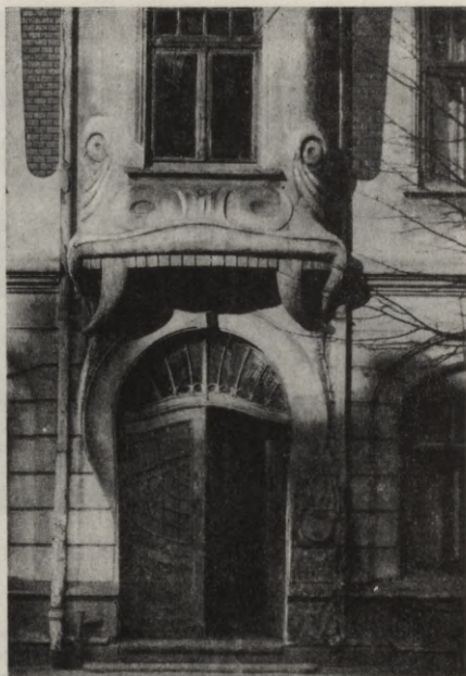
Portāla veidojums ēkai Tallinas ielā 23. Arh. K. Pēksēns. 1901.
