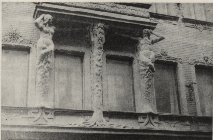
Fasādes rotājums ēkai Smilšu ielā 2. Arh. K. Pēksēns. 1902.
