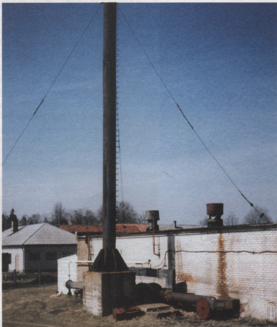
Kurtuve Ropažu centrā, kur pārsvarā dedzina dabas gāzi, lai iegūtu siltumu. Dabas gāze nesatur sēra savienojumus
