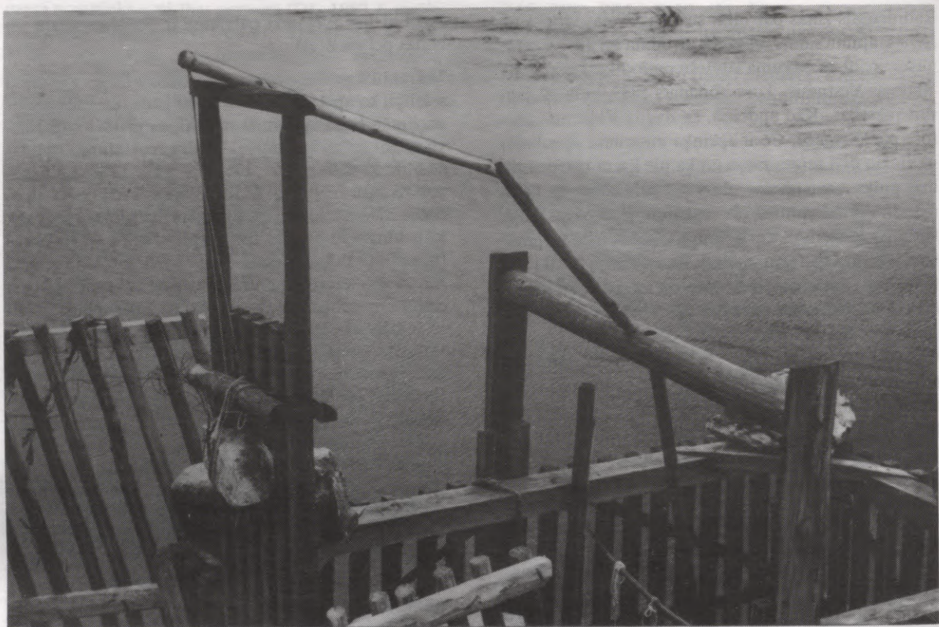
73. att. Lašu būra paceļamo vārtiņu sprūda kopskats Stāvūžkaula taci Daugavā pie Doles salas 1961. gadā (E 867. filma, 17. neg.).
