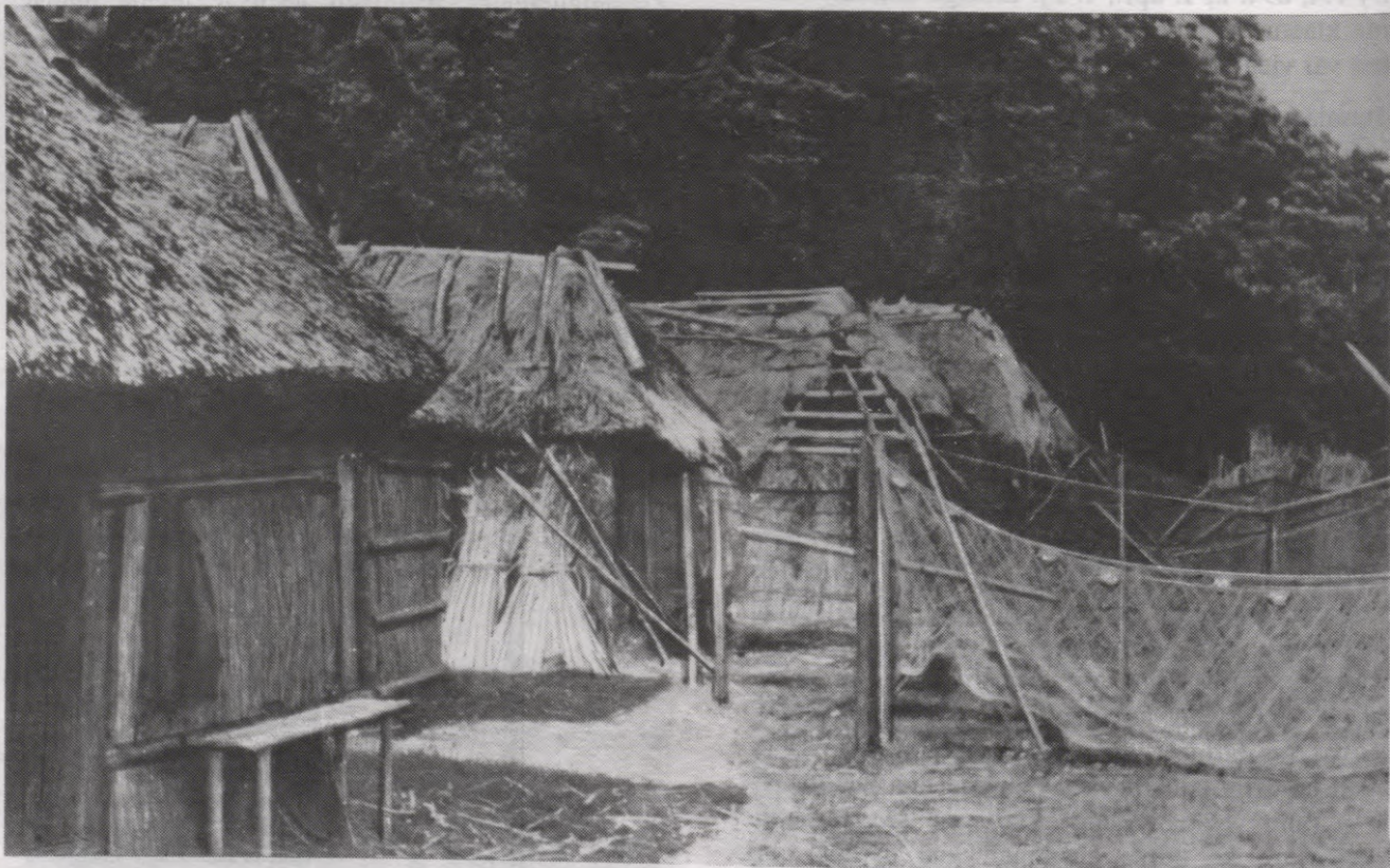
46. att. Pie Liepājas ezera uzcelto tīklu būdu rinda 1936. gadā. Būdu sienas veidotas no niedru kūļiem vai vismaz apliktas ar tiem. Attēla labajā pusē vabās pakārti žāvējamie liekaču tīkli (Rīgas kinostudijas bijušā skaņu operatora Valdemāra Blumberga dāvinājums autoram).
