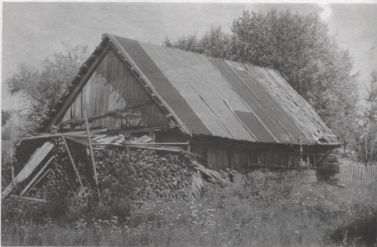
40. att. 1866. gadā celtā divtelpu klēts divām vaļinieku ģimenēm Talsu raj. Rojas pagasta Ģipkas Jokes 1993. gadā. Jumts lāpīts ar ruberoīdu pirms dažiem gadiem (E 1993. gada ekspedīcijas foto).
