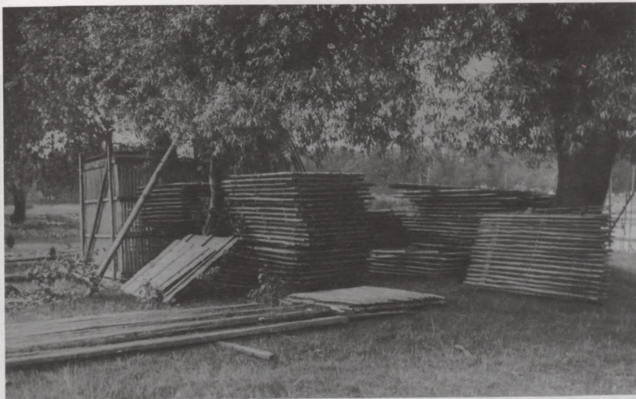
81. att. Carnikavas Nabiešu nēģu—lašu tača būvei Gaujumalā savestie un sagrēdotie materiāli 1961. gadā. Kreisajā pusē lašu būris (E 873. filma, 10.–17. neg.).
