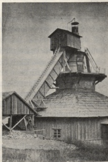
12. att. Rīgas cementa fabrikas C. M Schmidt modernais kaļķu ceplis (ar automātisku iekraušanu) Mazciecerē.
