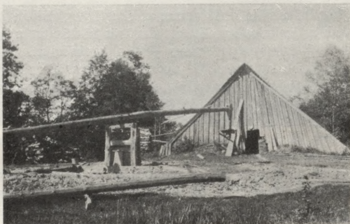
7. att. Tūjas Jūrasdzeņu ķieģeļnīcas mālu mīcītājs un ķieģeļu cepļis.
