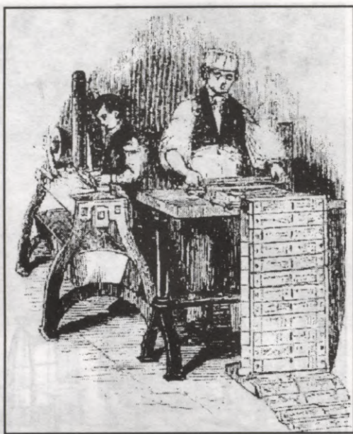
92. attēls. Perfokaršu izgatavošana Žakāra stellēm.
