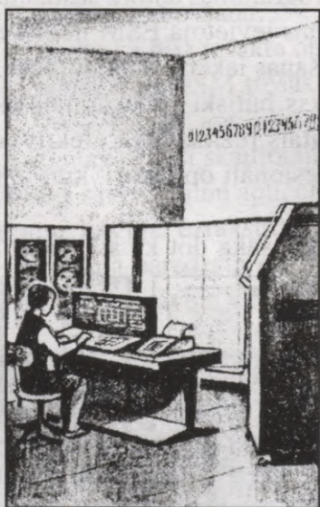
152. attēls. Tipisks otrās paaudzes skaitļotāju izskats. Viena ESM aizņēma "tikai" dažu dzīvokļu platību (daudzdzīvokļu ēkas vienu stāvu).
