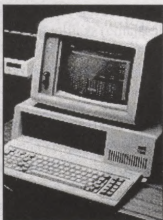
198. attēls. IBM PC. Sākuma modelis ar 16 KB atmiņu maksāja 2495 dolārus, līdzīgi kā Apple-II . Atmiņas palielināšana līdz 256 KB no pircēja prasīja vēl $ 1000, bet krāsainā monitora iegāde – vēl $ 750.
