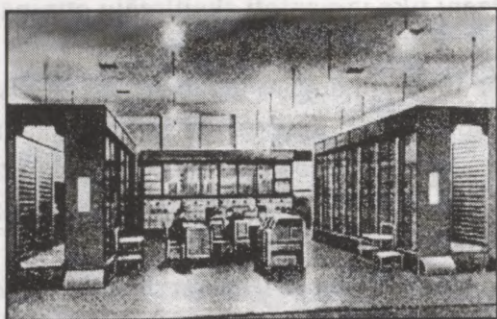
137. attēls. Padomju Savienības ESM БЭСМ. Tā sastāvēja no 8000 elektronu lampām un 4000 pusvadītāju diodēm.
