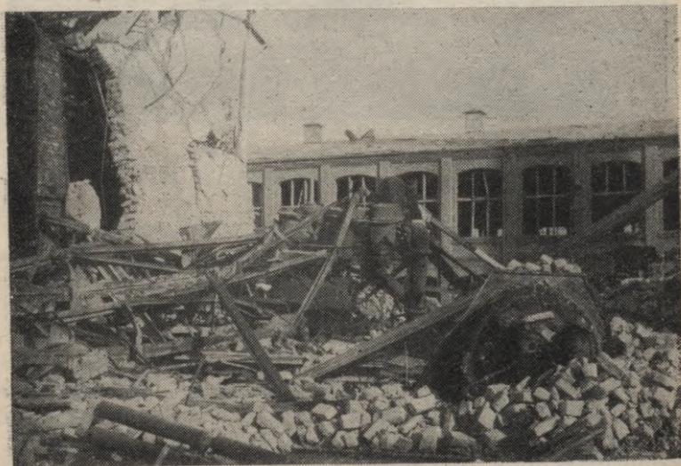
No sagraudās elektrostacijas un katlu telpas gruvešiem baismīgi rēgojās dzelzs lūžņi
