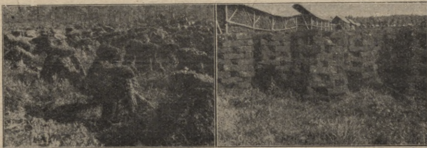
22. att. Pa kreisi — kūdras ķieģeļu apžāvēšana statņveida krājumā. Pa labi — kūdras žāvēšana, sakrauļot mazos gredzenos.
