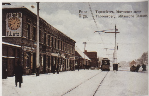
Torņakalns. Jelgavas šoseja. Pa kreisi – Teodora Luca pulkstenārbūvniecība ēkā (civilinženieris Edmunds fon Trompovskis, 1894.gads) Jelgavas šosejas un Satiksmes ielas stūrī.
