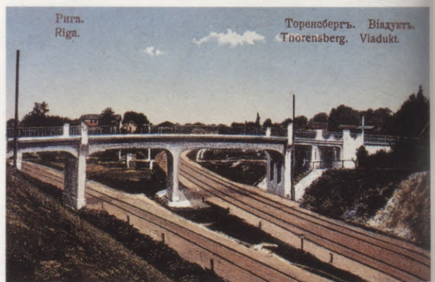
Torņakalna viadukts Kapu (tagad Torņakalna) ielā. Tas šķērso Rīgas–Jelgavas (pa kreisi) un Rīgas–Tukuma (pa labi) dzelzceļa atzarus.
