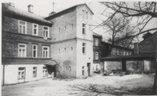
6. zīm. Divstāvu māja ar mūra cokļstāvu (puspagrabu), ugunsdzēsības vienā galā un 15 dažādiem (1-3 istabu) dzīvokļiem. Lapu ielā 3 b , skats no pagalma. 1899. g. Arh. tehn. V. Hofmanis
