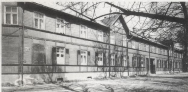
8. zīm. Divstāvu māja ar trim kāpņu telpām - sekciju mājas prototips. 24 dažāda lieluma (1-5 istabu) dzīvokļi. Amālijas ielā 5 a . 1912. g. Arh. O. Bārs
