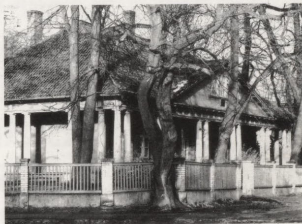
Bijusi Torņakalna aptieka Vienības gatvē 27, Blokmužiņa ar kolonnām, tagad bibliotēka
