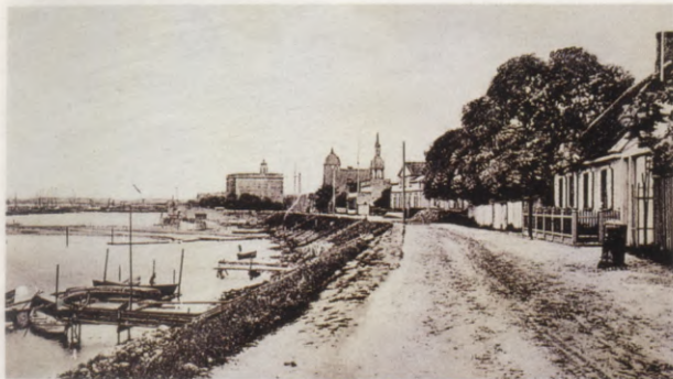
Balasta dambis. Skats Āgenskalna liča virzienā.
