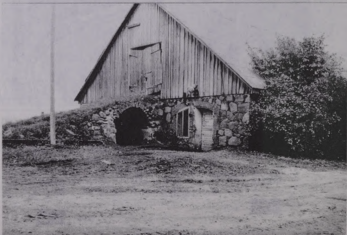
4.34.att. Uzbrauktuve Vecsaukas muižas kūti 1995.gada septembrī.
