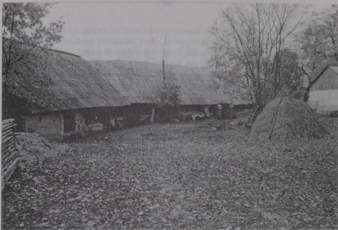
4.56.att. "Ormaņu" leņķa kūts (foto, 1995.g.).
