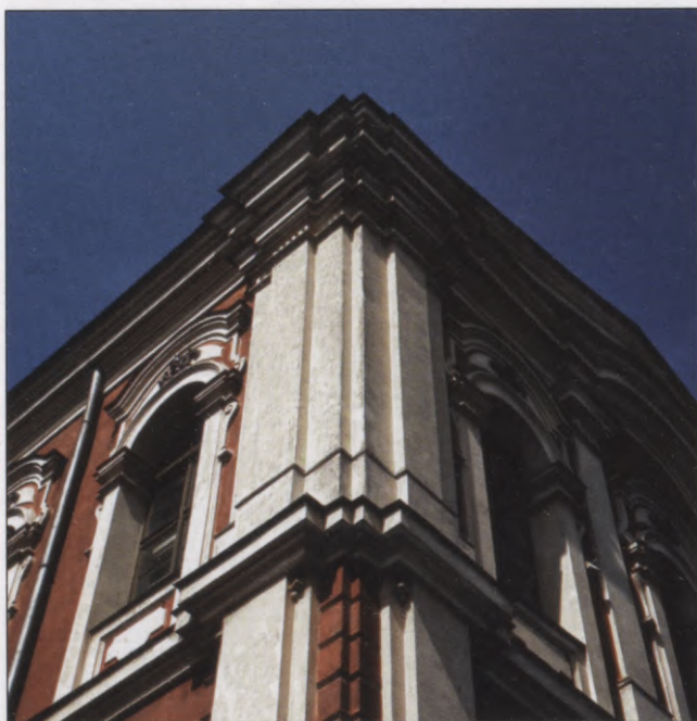
103. Fasādes stūris Façade corner
