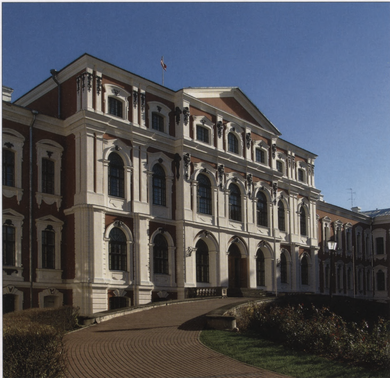
113. Galvenā korpusa pagalma fasādes centrālais rizalīts Central risalite of the main block, courtyard façade
