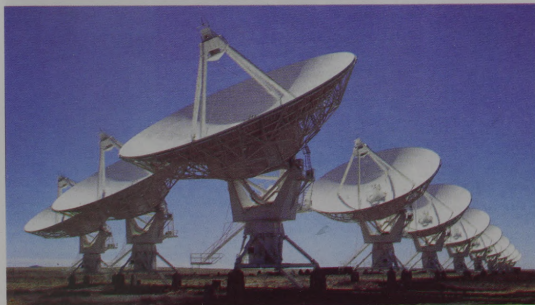
Radioteleskops VLA (Very Large Array), kas sastāv no 25 m diametra 27 antenām (Jaunmeksikā, ASV). Attēlā redzamas 11 antenas.
