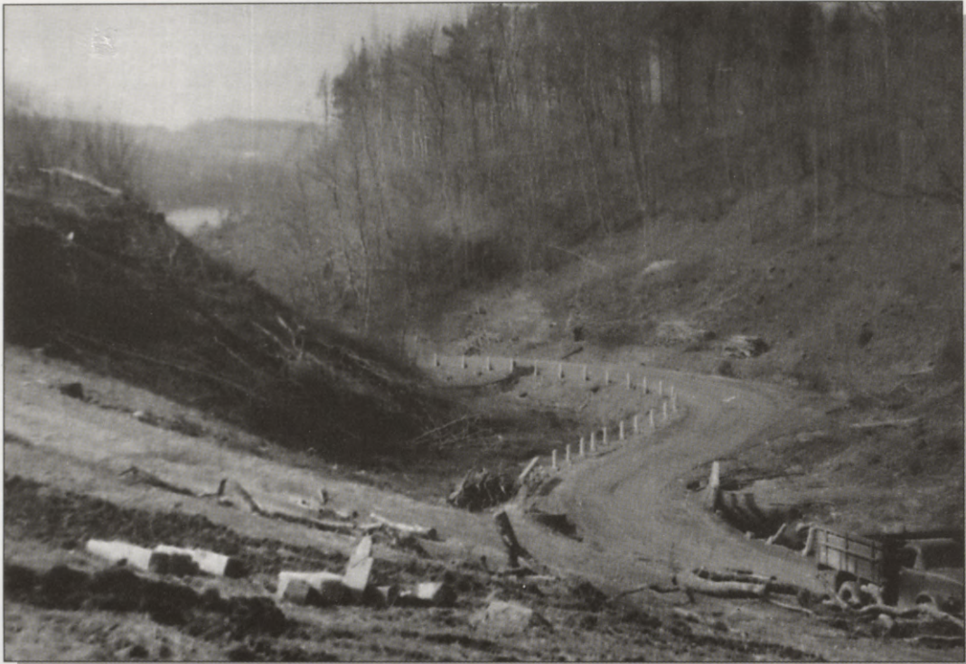
HELENAS UPĪTES GRAVA. KOKU IZCIRŠANA SAKARĀ AR SPEKSTACIJAS BŪVI AIZKRAUKLE UN PAREDZAMO APPLŪDINĀŠANU 1963. GADĀ
