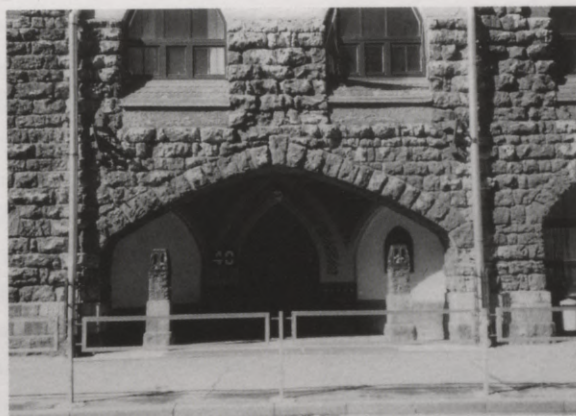
9. A. Ķeniņa skolas ēkas fasādes fragments
