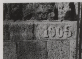
10. A. Ķeniņa skolas ēkas fasādes fragments
