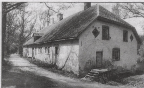
Pirmā HES ēka (bij. pirts), 1983.g. foto. Nojaukta 1986.gada pavasarī
