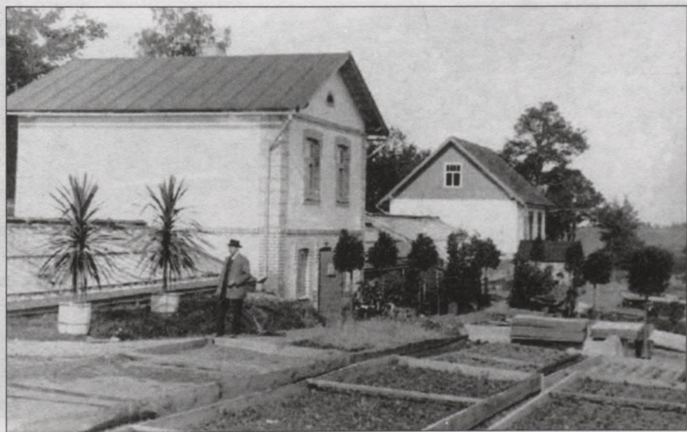
Kārļa Antēna dārzniecība Valņu ielā. 1932.gads (Foto restaurēts no A.Pirro negatīva)
