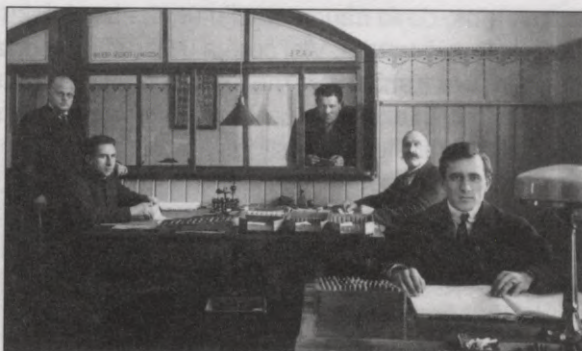
Bankas kantora telpas (1936.g.) Dārza ielā 11
