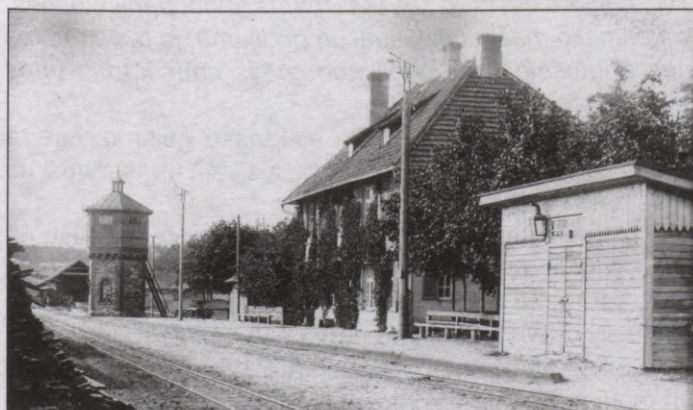
Smiltēnes stacijas ēka. Tālpānā ūdenstornis
