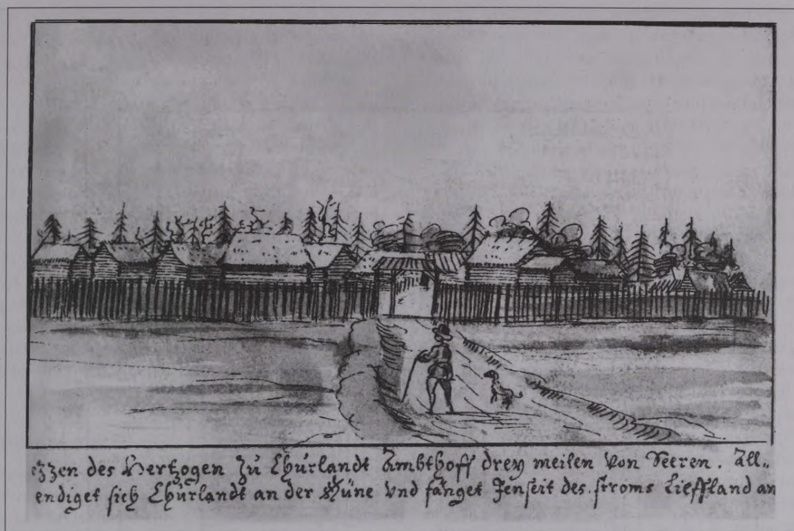
3. att. J. R. Šturna 1661. gadā skicētā Kurzemes hercogistei piederošā Seces muiža. Priekšplānā stāvkoku žogs un augsti, ar jumtiņu segti vārti. Visām ēkām guļbaļķu sienas krusta pakšos. Jumti – salmu, dēļu vai lubu. Būvju izmantošana nav nosakāma (PI 51. lp.)
