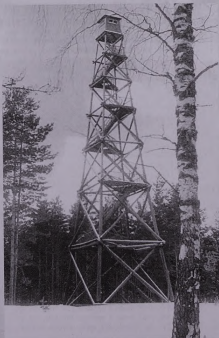
Uguns novērošanas tornis Rideļos. Koka konstrukcijas būvētas 1946. un 1947. gadā. 70.gadi. A. Liepiņas foto. TMNM 39550
