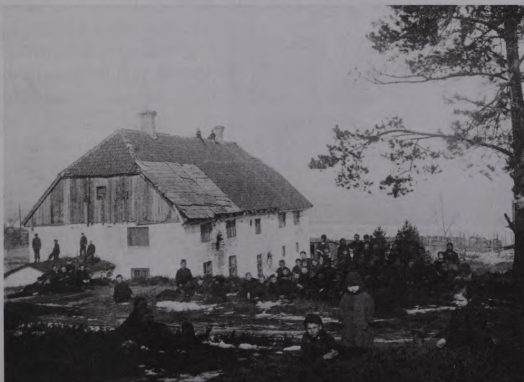
Vecais spīķeris pirms pārbūves un skolas ierīkošanas. 1923. gads. Fotogrāfs nezināms. Attēls no albuma "Apšucie- ma kulturālā izaugsme padomju varas gados". TMNM 9076
