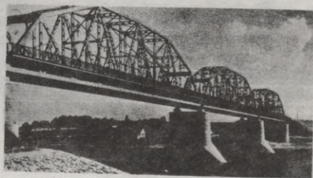
(augstāk) Dzelzceļa tilts pār Daugavu starp Krustpili un Jēkabpili, uzbū- vēts 1936-37.g.; ar 3, apm. 100 m ga- rām kopnēm starp pīlariem un 2 krasta kopsieniņu sijām. Materials - augst- pret stības tērauds.
