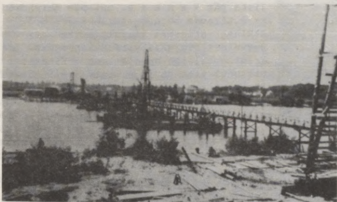
Pīlaru un krasta balstu būvdarbi Gaujas tiltam pie Carnikavas uz Rīgas-Rūjienas līnijas.
