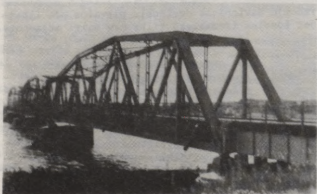
Tilts pār Gauju pie Carnikavas uz jaunbūvētās Rīgas-Rūjienas līnijas - pēc satiksmes atklāšanas 1934. gadā. Tilts ir ar 3 tērauda kopņu pār-laidumiem ē 60 m ar 3 upes pīlariem ar kesonu pamatojumu.
