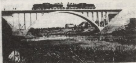
Salacas tilta stātiskā pārbaude ar 2 smagākām pasažieru lokomotīvēm pirms nodošanas ekspluatācijā.
