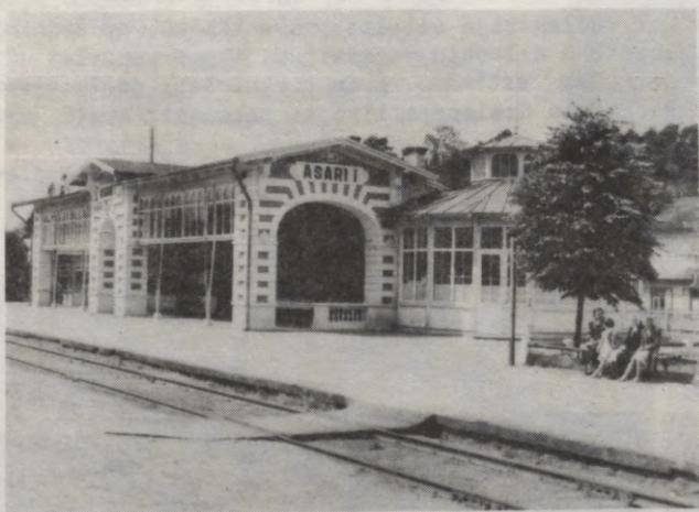
Stacijas-pieturas ēka "Asari I" uz Rīgas-Slokas līnijas. Rosīgi darbojās Rīgas jūrmalas peldsezonas laikā. Celta ap 1925.g.
