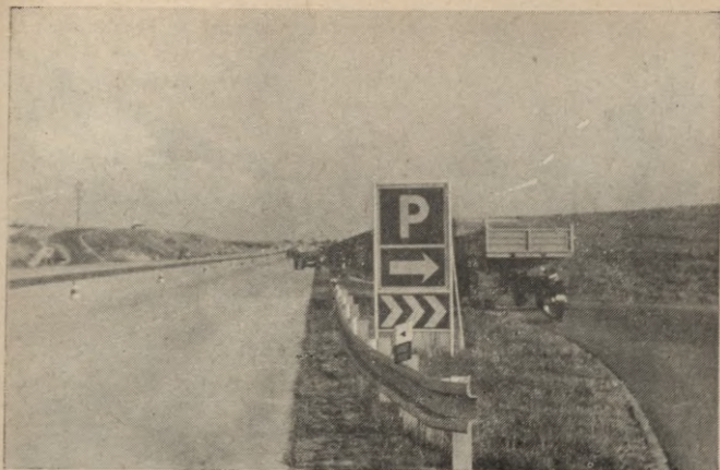
174. att. Puselastīgās profiltērauda barjeras
