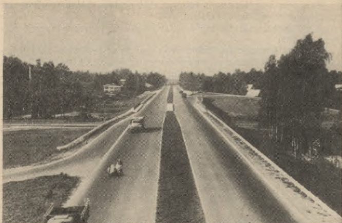
173. att. Neelastīgās dzelzsbetona barjeras Rīgas-Ogres ceļā
