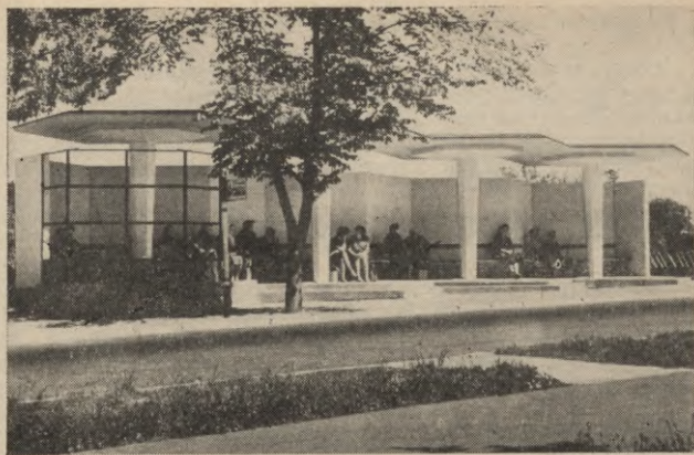
179. att. Erts autopaviljons ar paaugstinātu platformu pasažieru iekāpšanai un izkāpšanai Rīgas-Pleskavas ceļā
