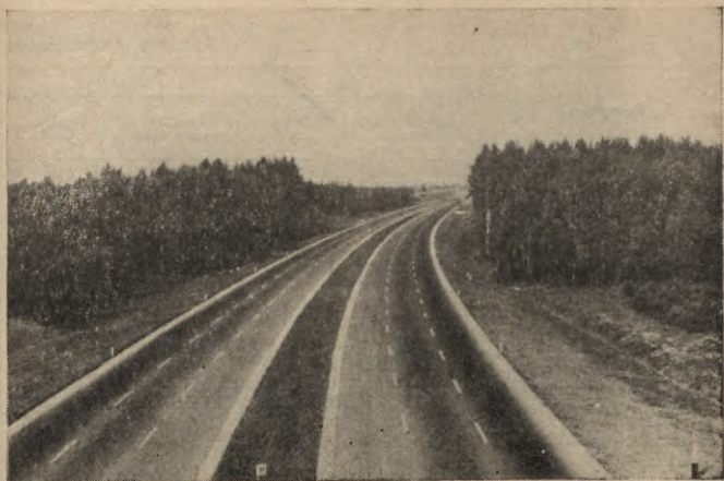
181. att. Rīgas-Jūrmalas kūrortceļš ar izbūvētām lēzenām (slīpums 1 : 4) nogāzēm
