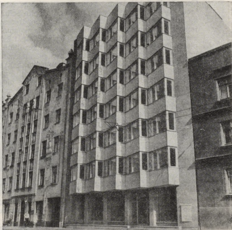
Dzīvojamā ēka Leņina ielā.
