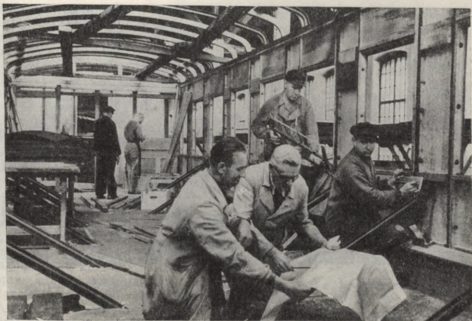
Pirmā elektriskā vagona būve Rīgas vagonu rūpnīcā 1946. gadā.
