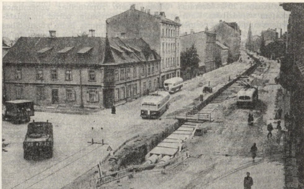
Termotrases izbūve Leņina ielā (1958. g.).
