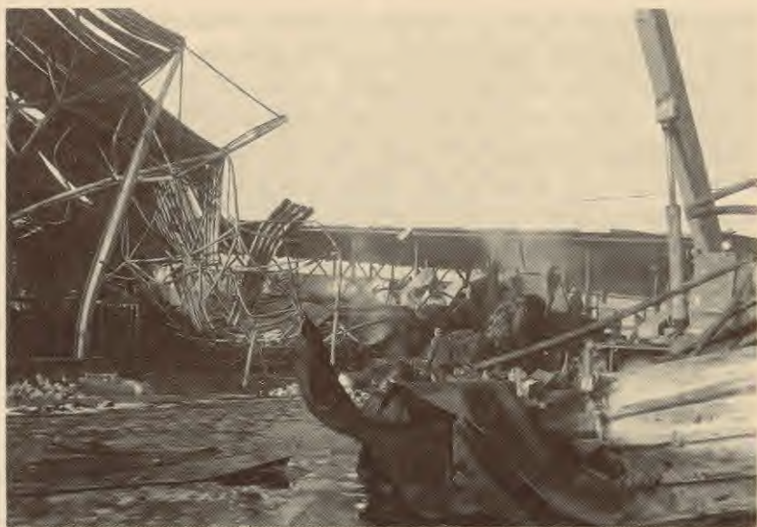
1992. gada janvāris. Pēc ugunsgrēka Rīgas tabakas fabrikas izejvielu noliktavā Lubānas ielā 80.
