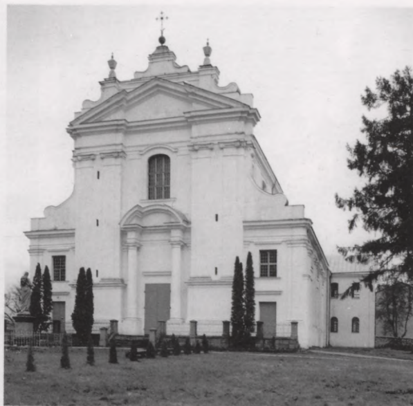
10. Krāslavas katoļu baznīcas fasāde. 2003
