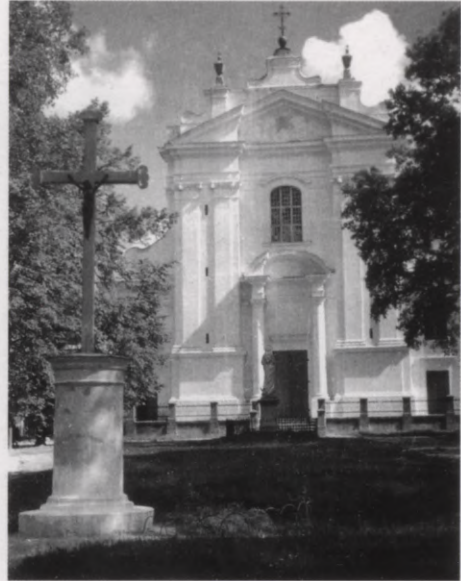
7. Krāslavas katoļu baznīcas fasāde. 1940
