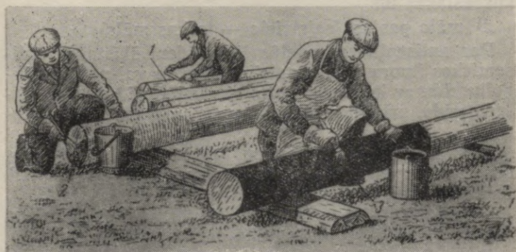
47. att. Koka stabu antiseptizēšana ar pastu: 1 — gala notēšana, 2 — pieres antiseptizēšana, 3 — gala antiseptizēšana
