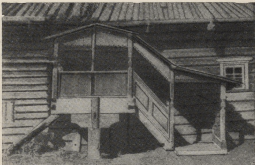
169. att. Archangeļskas apg. Verchnijas Tojemskas raj. Pridvorovas ciematā XVIII gadu simtenī celtā dzīvojamā ēkā: ārējās kāpnes aizsargātas ar juntu.
