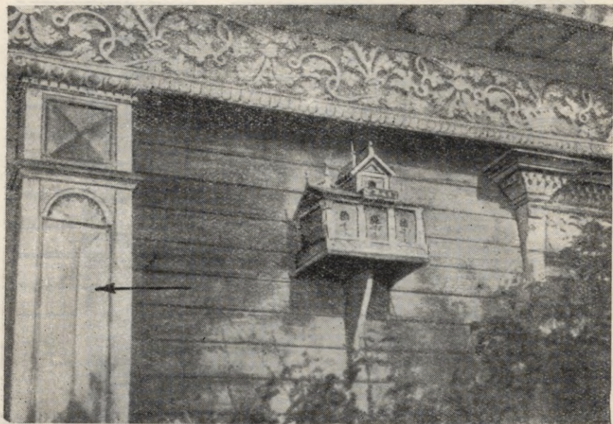
64. att. Gorkijas apg. Gorodeckas raj. Sologuzovas ciemā XIX gs. otrā pusē celtā dzīvojamā ēka: ar bultu parādīts pakšu nosegums ar dēļiem
