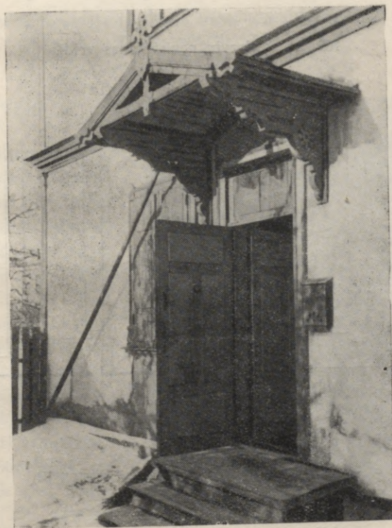
161. att. Ārdurvis pārsegta ar uzjūnteni.
