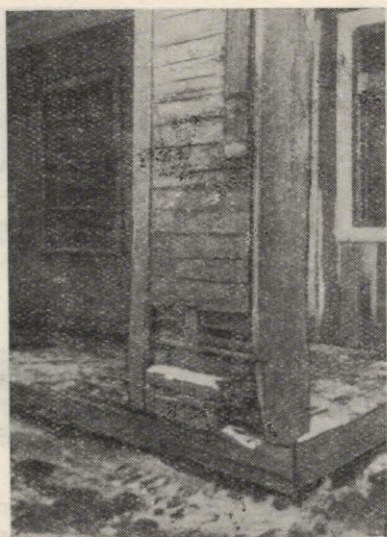
79. att. Ilgstošā atmosfēras mitruma ietekmē (norautās ūdens novadcaurules dēļ) koka ārsienai ir satrupējusi apakšējā josla.
