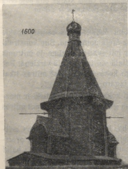
62. att. Archangeļskas apg. Augš-Tojemas raj. Vijskā 1600. gadā celtā Elijas baznīca: ar bultām parādīti ar dēļiem nosegtie sienu stūru pakši.
