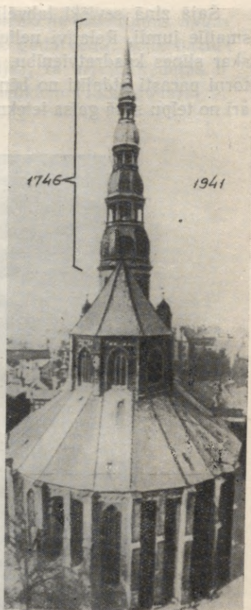
136. att. 1746. gadā celtais Rīgas Pēterā baznīcas tornis.
