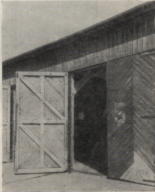
165. att. Vārti veras uz āru.
