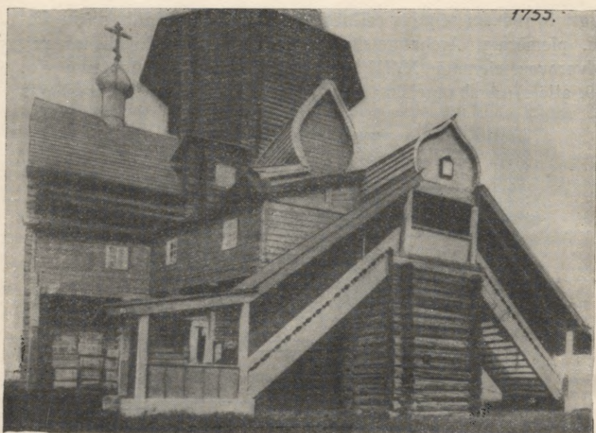
170. att. Archangeļskas apg. Vinogradovskas raj. Rostovskajas ciematā 1755. gadā celtā Flora-Lavras baznīca: ārējās kāpnes aizsargātas ar jumtu.
