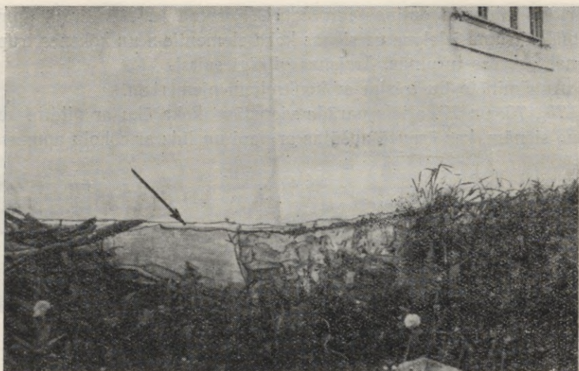
75. att. Pamatu cokola un koka sienas vienlaida apmetums: nepareizs paņēmieni.
