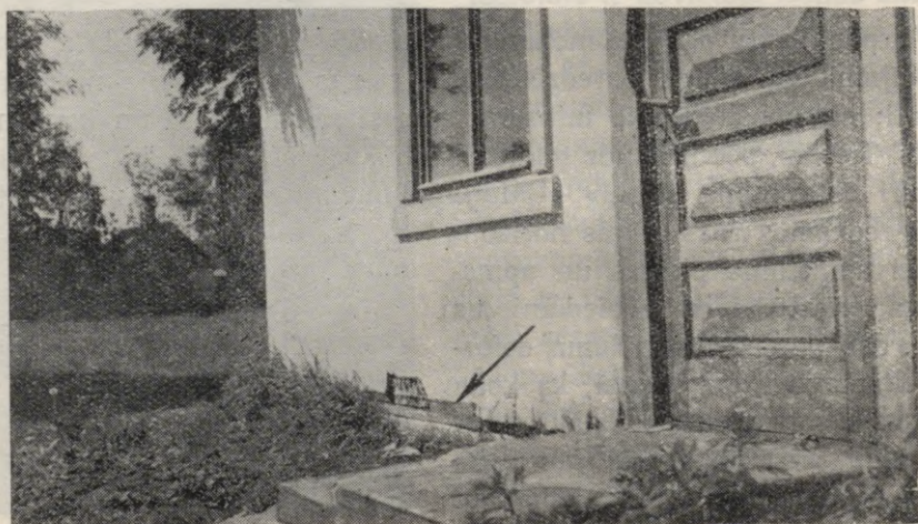
76. att. Koka ārsienas sēšanās sakarā ar satrupējušā apakšējā vaiņaga deformācijām (saspiešanos).
