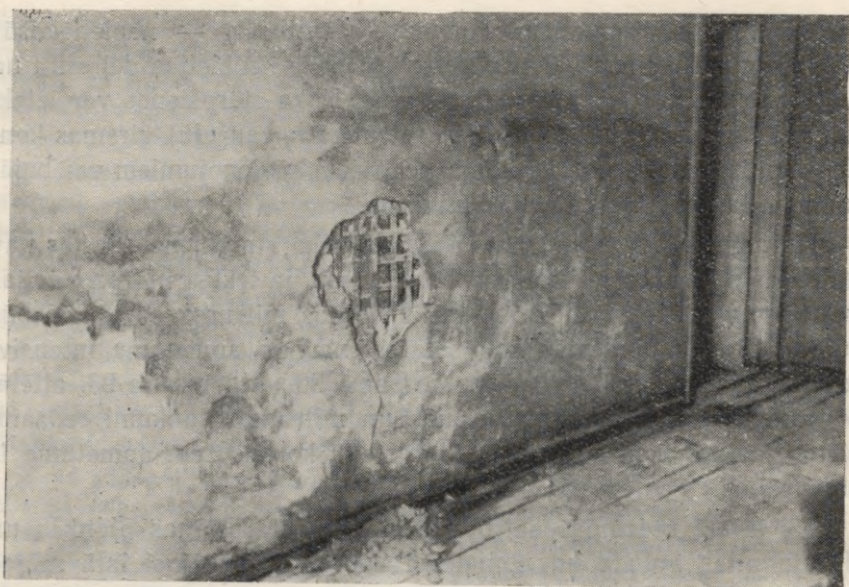
91. att. Trupēšanas procesa attīstīšanās koka starpsienā hidroģeoloģiskā mitruma ietekmē.
