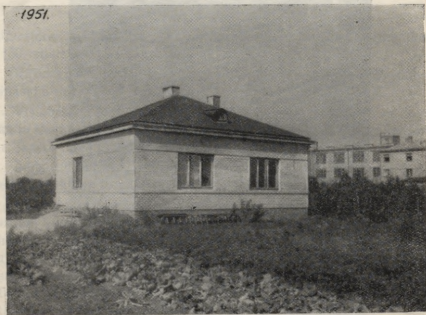
152. att. Vērtnes bez šķērsi- šiem 1951. gadā celtā individualā dzīvojamā ēkā Rīgā, Braslas ielā.
