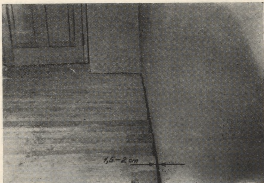
114. att. Aerācijas atstarpe starp tīro grīdu un sienām.
