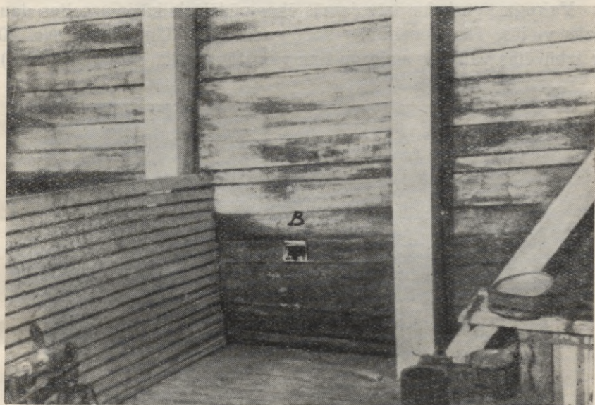
81. att. Hidroģeoloģiskā mitruma ietekmē satrupējusi koka siena.
