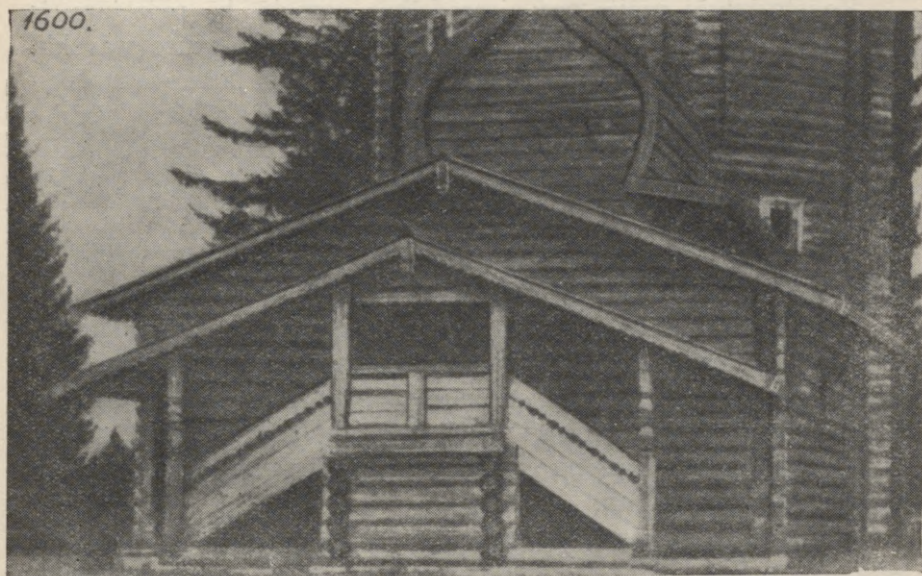
172. att. Archangeļskas apg. Paņilovas ciematā 1600. gadā celtā Nikolaja baznīca: ārējās kāpnes aizsargātas ar jumtu.
