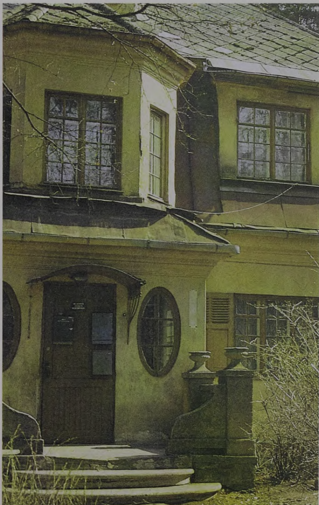
Arhitekta G. fon Tizenhauzena vienģimenes dzīvojamās mājas Štepecas ielā 5 fasādes fragments
