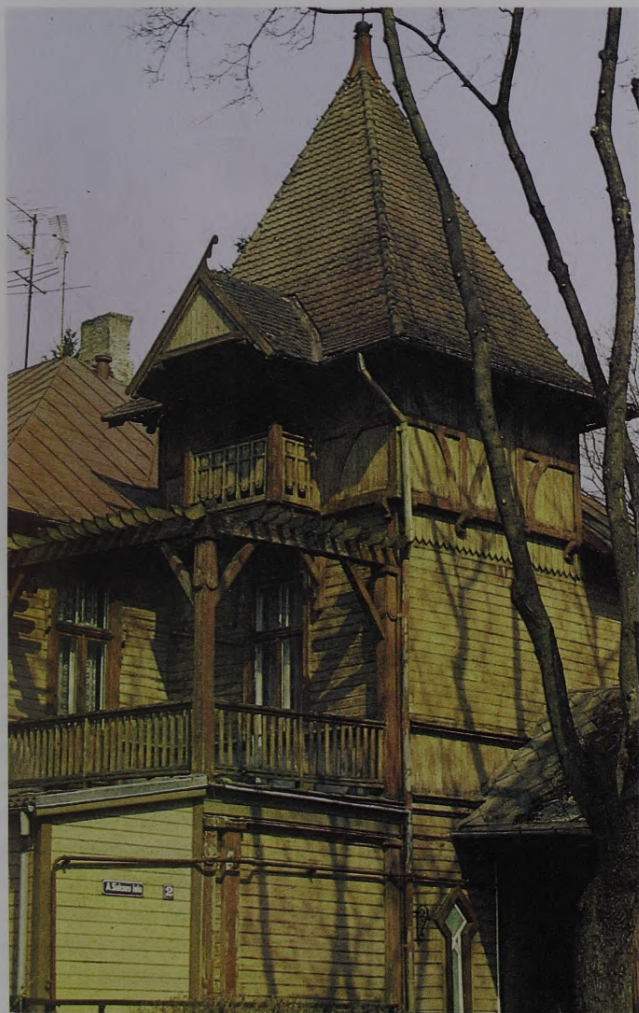
Vienģimenes dzīvojamā māja A. Sakses ielā 2. Fasādes detāļa
