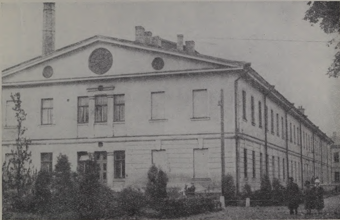
Боковое крыло каменного корпуса бывш. Рижского военно-сухопутного госпиталя.
