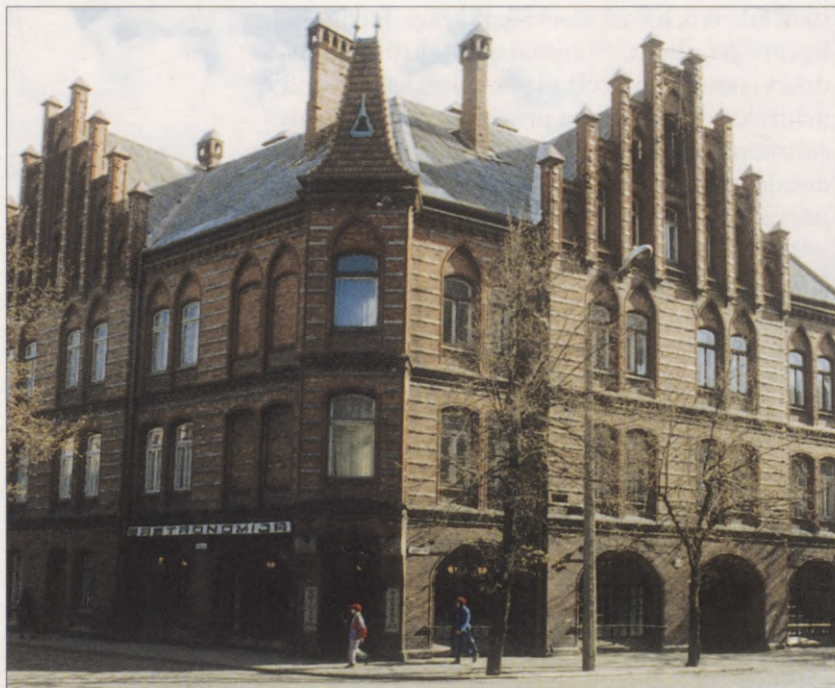
122. attēls. V. Rīges nams Liepājā, Peldu ielā 44. 1902. Arhitekts M. Berči
