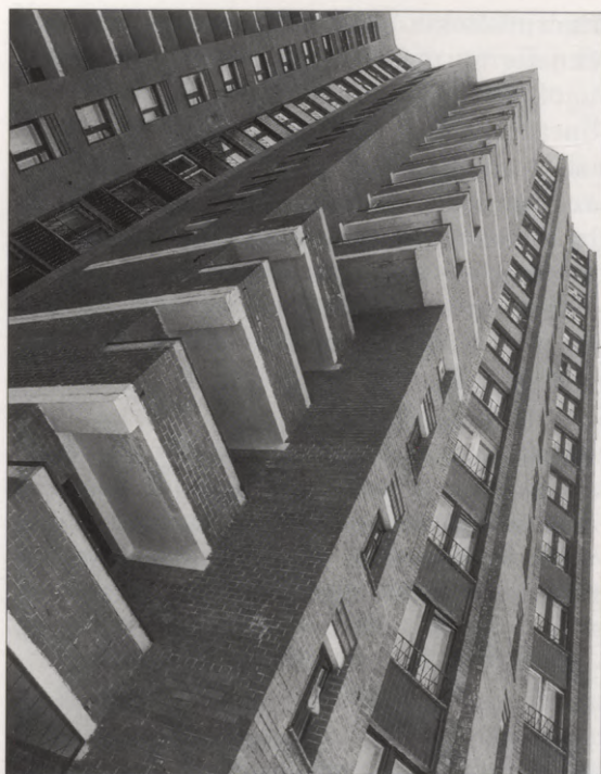
358. attēls. Dzīvojamā ēka Rīgā, Anņimuižas bulvārī. 1984—1992. Arhitektes V. Rauhvargere, Z. Kalinka
