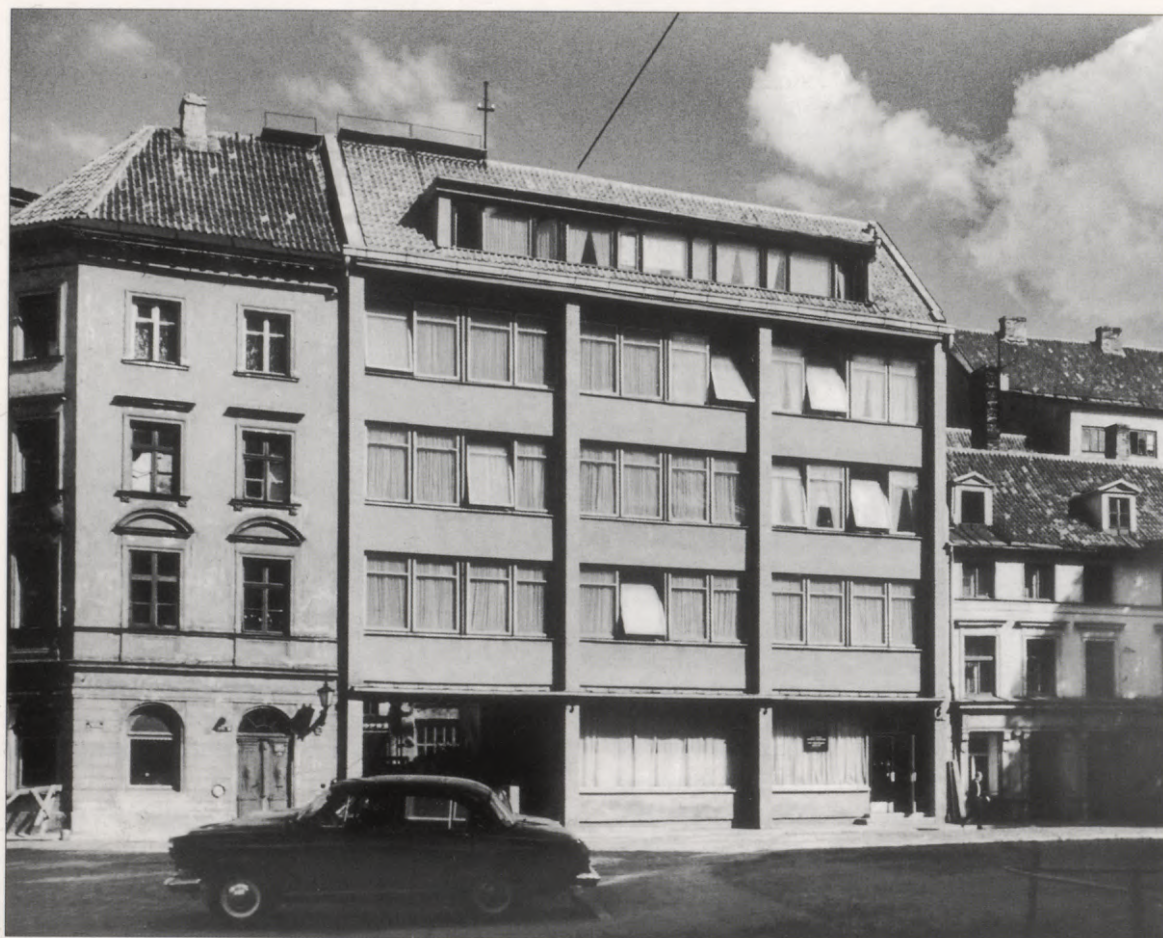
269. attēls. Latvijas zvejnieku kolhozu valdes ēka Rīgā, Doma laukumā. 1967. Arhitekts D. Danneberga
