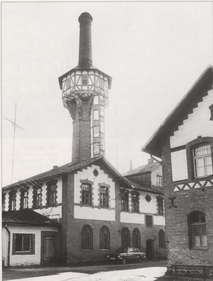
125. attēls. Strenču psihiatriskās slimnīcas katlumāja ar skursteni- ūdenstorni. 1904—1908. Arhitekts A. Reinbergs
