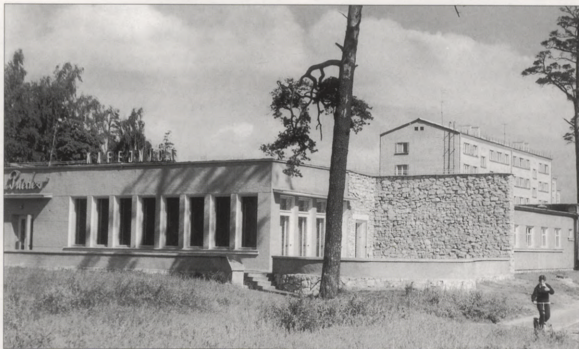
247. attēls. Kafejnīca «Priedes» dzīvojamā rajonā «Āgenskalna priedes». Arhitekts G. Irbīte
