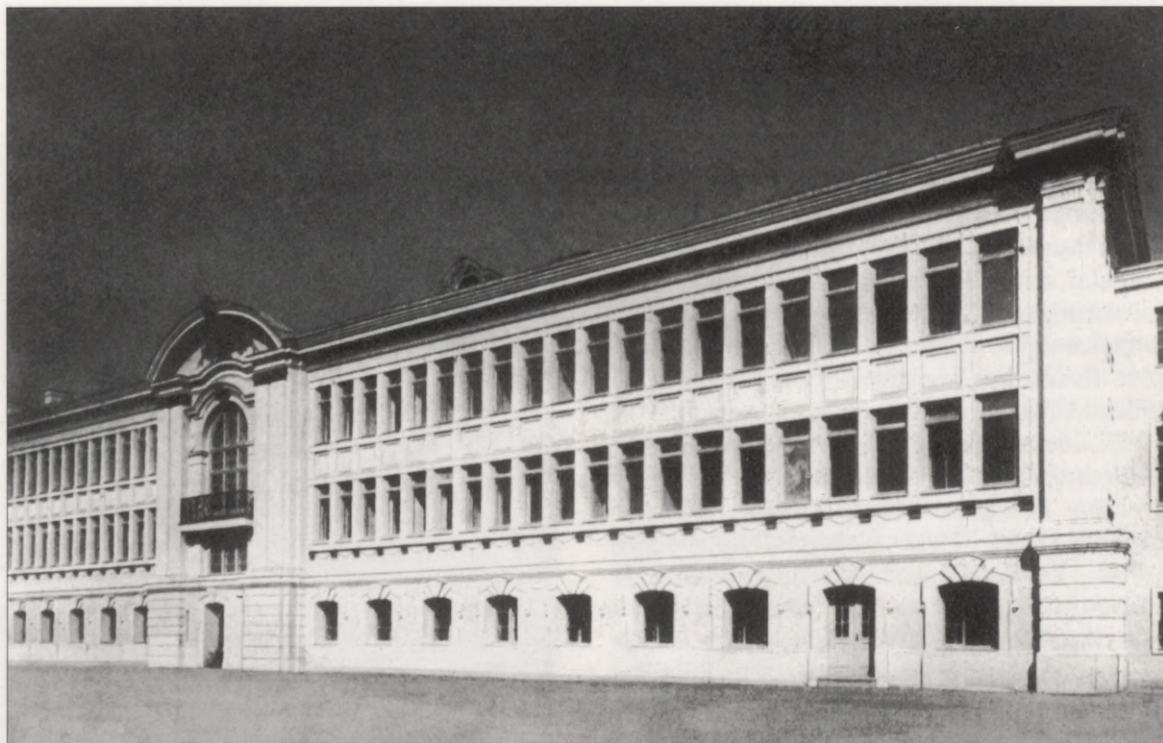
229. attēls. Jelgavas pils dienvidu spārns. 1937. Arhitekts E. Laube. Pārveidots pēc 2. pasaules kara
