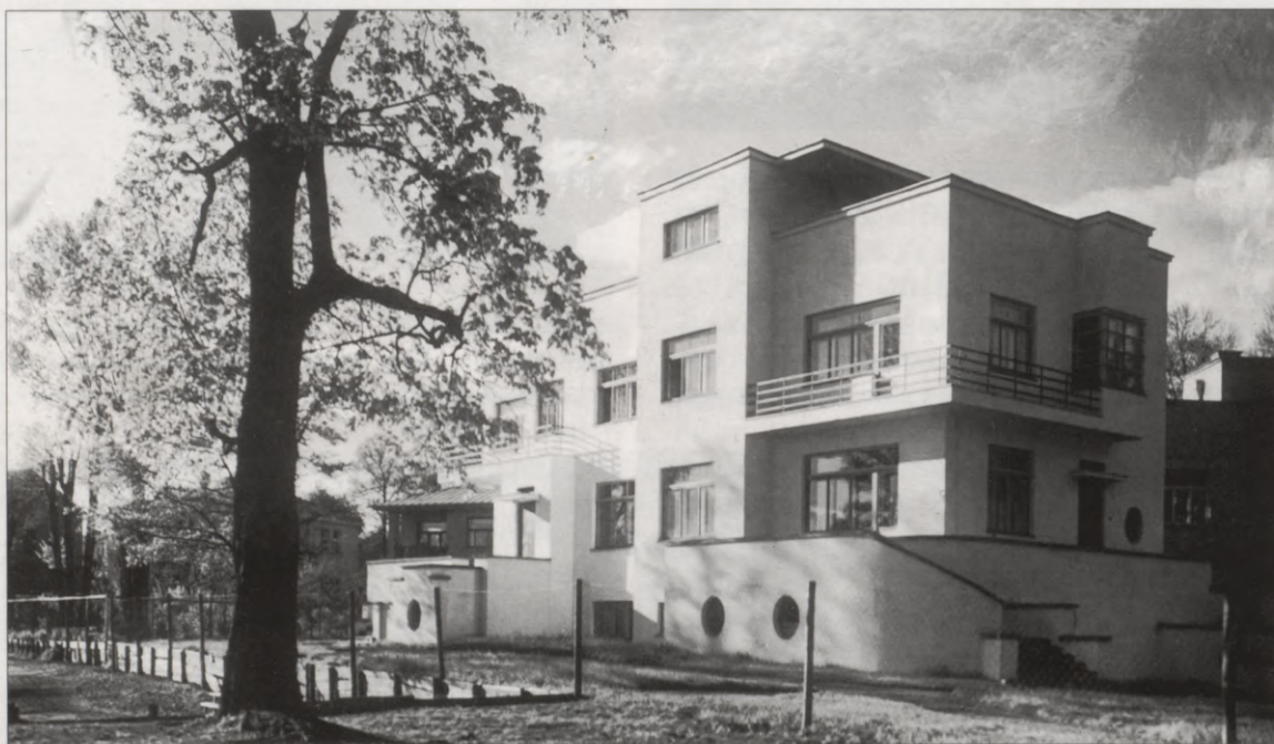
207. attēls. Savrupmāja Rīgā, O. Vācieša ielā 13. 1931. Inženieris T. Hermanovskis. Pārbūvēta 60. gados
