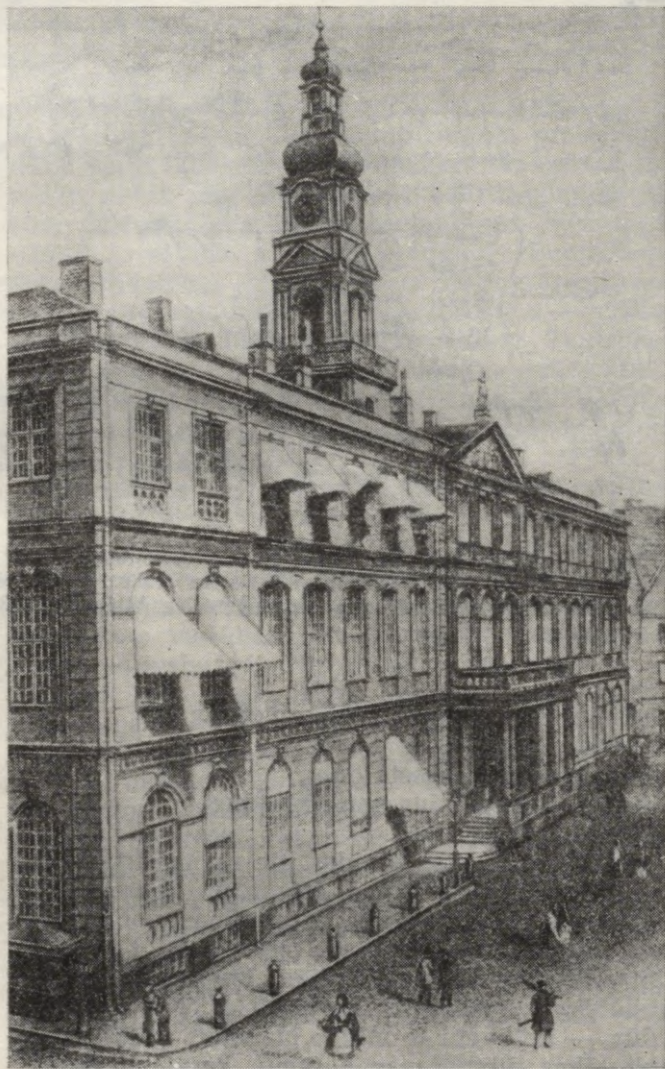
Bijušais Rīgas pilsētas rātsnams, kur no 1891. līdz 1941. gadam atradās Rīgas pilsētas bibliotēka. Nodedzinātā Rātsnama vietā 1958. gadā uzcelta tagadējā Rīgas Politehniskā institūta galvenā ēka (Leņina ielā 1).
