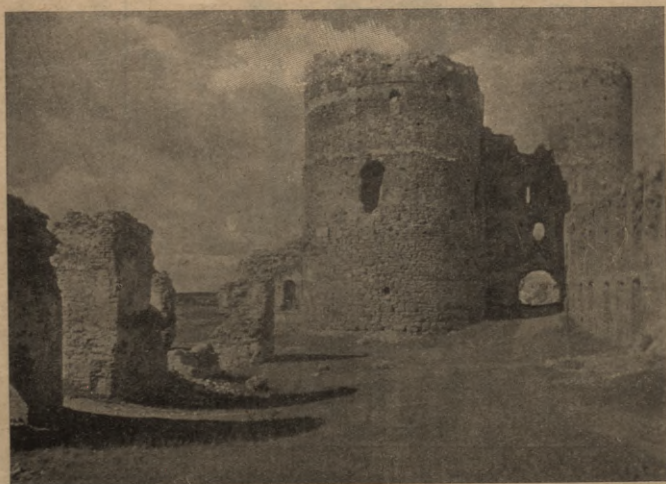
Nr. 18. Ordensvogtei Bauske , Innenansicht.
