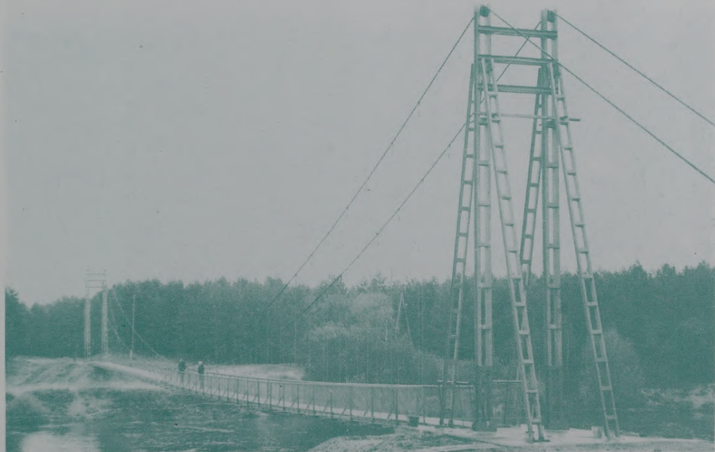
2. attēlā redzams pēc šāda projekta būvēts kājnieku tilts pār Gauju pie Rāmnieku mājām. Tilta laidums ir 120 metri. To projektējuši un būvējuši 3. ceļu ekspluatācijas rajona inženiertehniskie darbinieki inženiera G.Pučes (1935.) vadībā.
