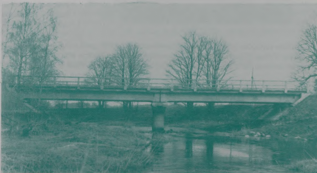
14. attēlā redzams pār Abavu uzbūvētā tilta kopskats.
