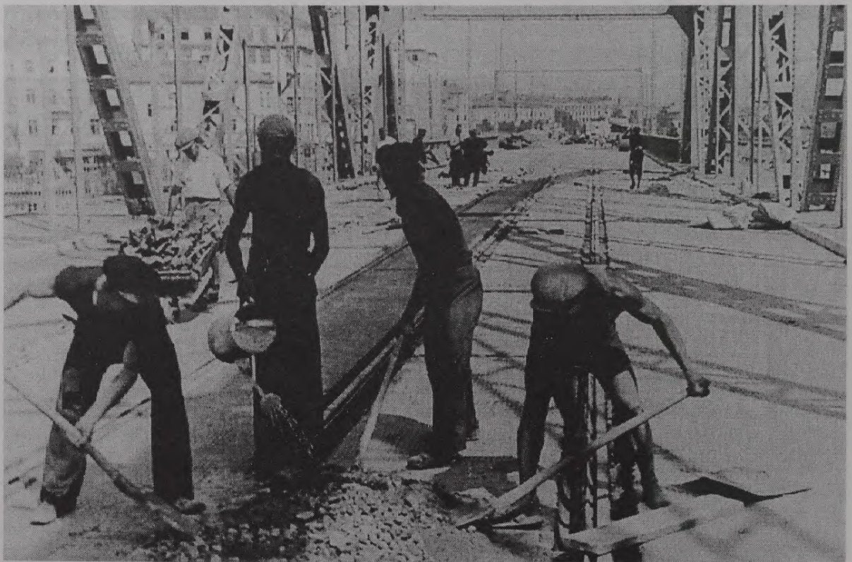
4. attēls. Strādnieki gatavo betonmasu tilta brauktuves izveidošanai starp tramvaja sliežu ceļiem.
