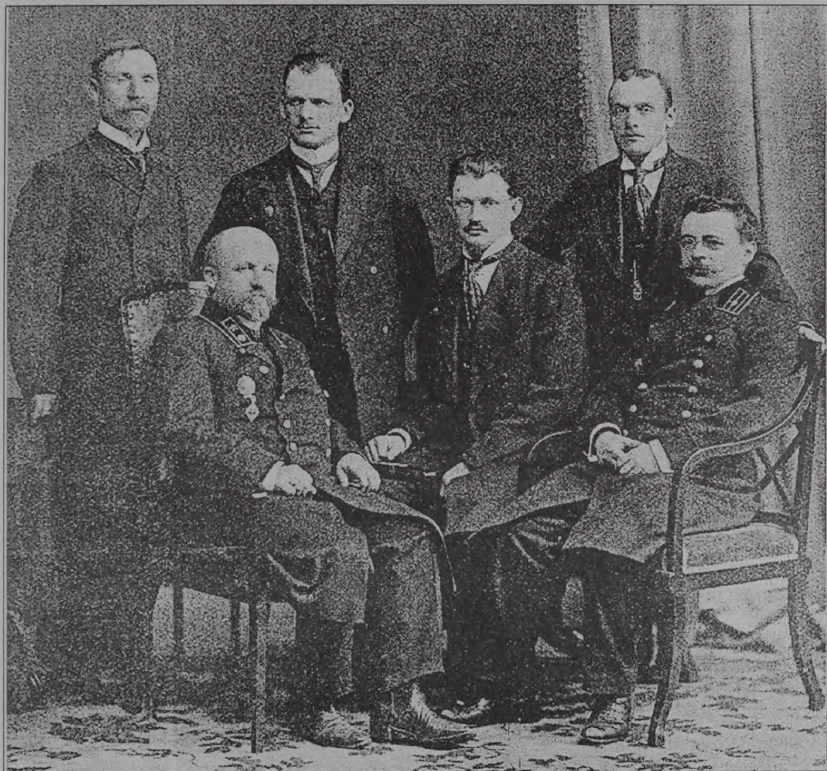
13. attēls. 1914. gads. Inženieris P. Pāvilāns sēž vidū, otrais no kreisās stāu inženieris A. Tramdaks, priekšā pa labi sēž Rīgas dzelzceļa mezgla rekonstrukcijas vecākais darbu vadītājs ģ. Baženovs, pa kreisi - dzelzceļa ceļu dienesta priekšnieks A. Verhouskojs.
