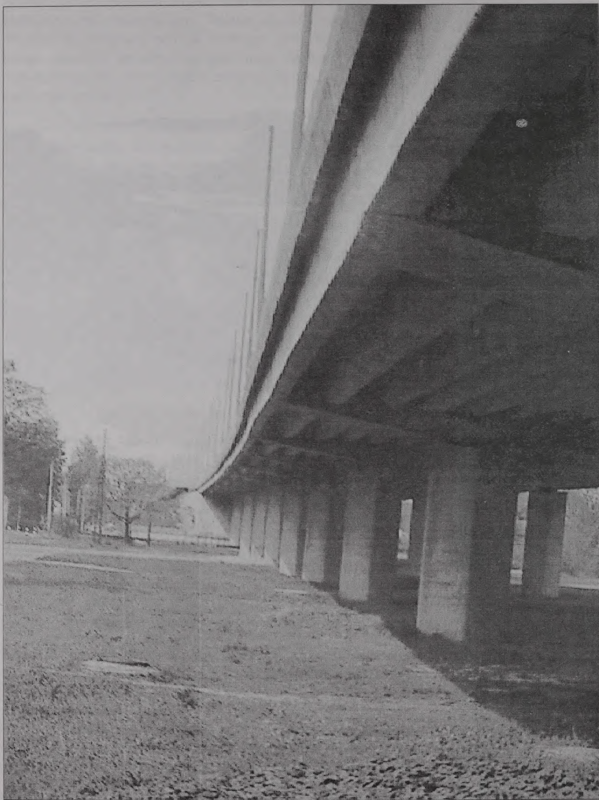
20. attēls. Pārvads pār Rīgas-Bolderājas dzelzceļu Jūrmalas gatvē.
