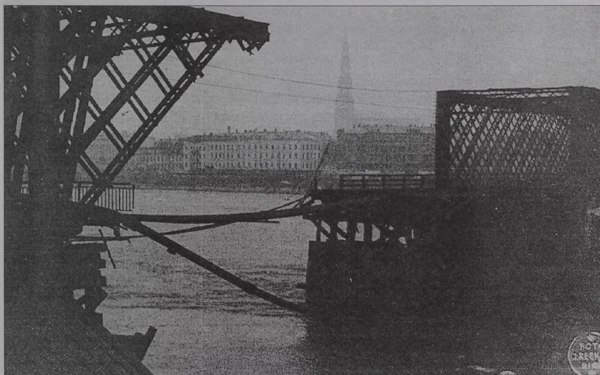
7. a t t ē l s. Zemgales tilta jaunus laidumus montējot, veco dzelzs tiltu pakāpeniski nojauca.
