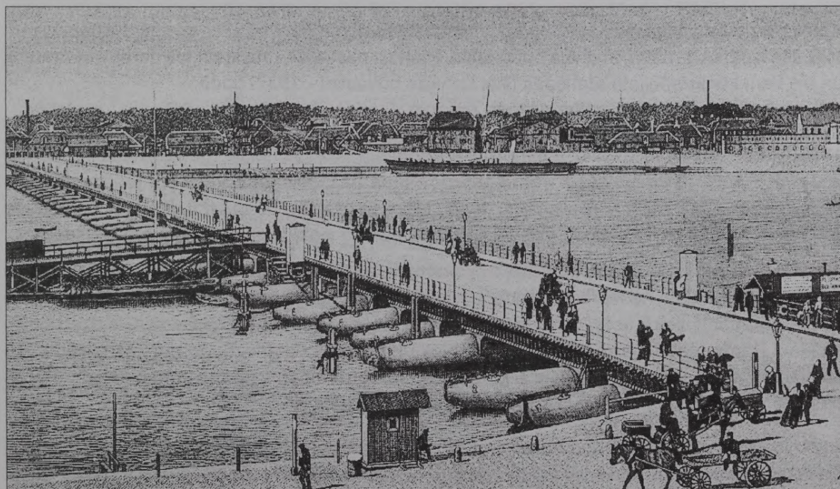
8. attēls. Rīgas pontontilts.
