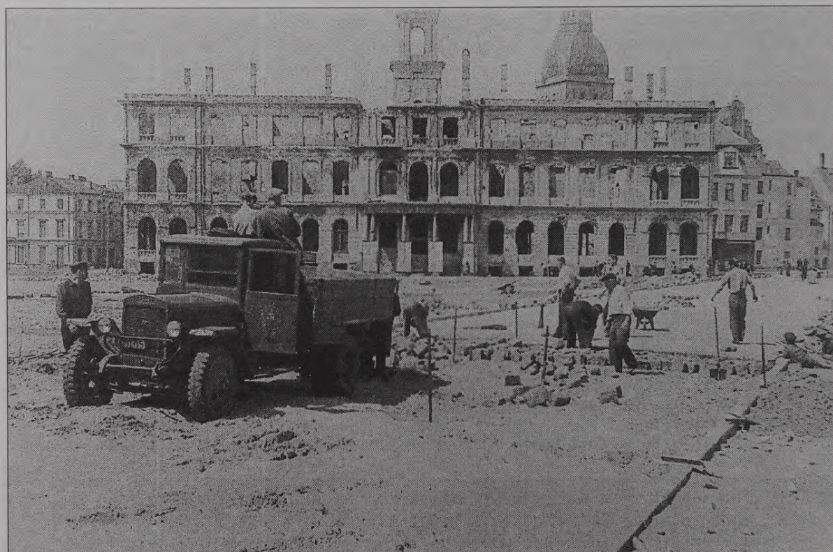
22. attēls. Tilta uzbrauktuves bruģēšanas moments Vecrīgā.
