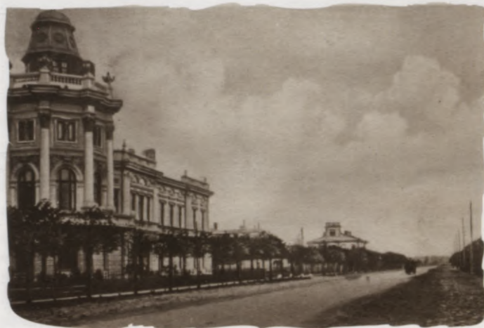
Bijusi Karostas radiotelegrāfa ēka tagadējā Atmodas bulvārī. Former Karosta Radio-Telegraph station on Atmodas boulevard.
