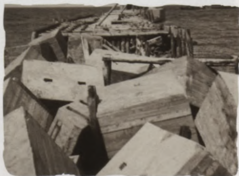
Molu celtniecība Construction of the breakwaters
