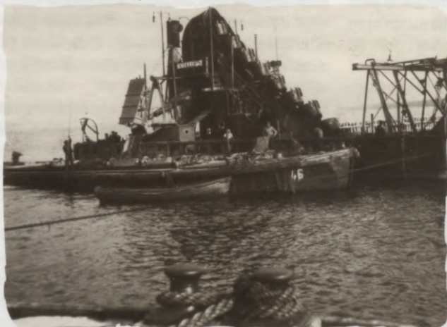
Karostas kanāla rakšanas darbi. Zemessmēļi. Karosta canal construction works. Floating dredger.
