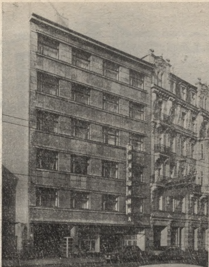
Dzīvojamais un veikalu nams Rīgā, Brīvības ielā 97. 1934. Arhitekts P. Mandelštams.
