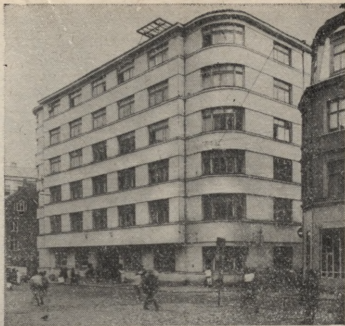
Telefonu centrāle Rīgā, Audēju ielā 15. 1935. Arhitekts D. Zariņš.
