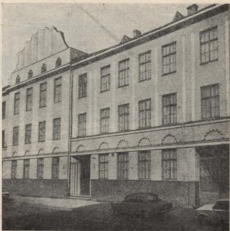
Telefonu centrāle Rīgā, K. Barona ielā 69. 1928. Arhitekts D. Zariņš.
