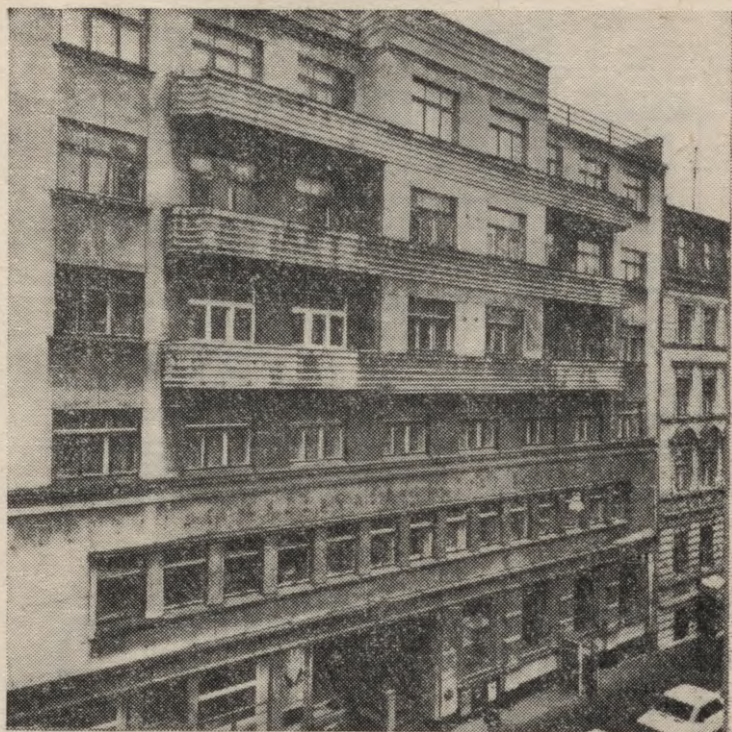
Latvijas Grāmatnieku arodapvienības nams Rīgā, Lāčplēša ielā 43/45. 1930. Arhitekti A. Kars, K. Betge.
