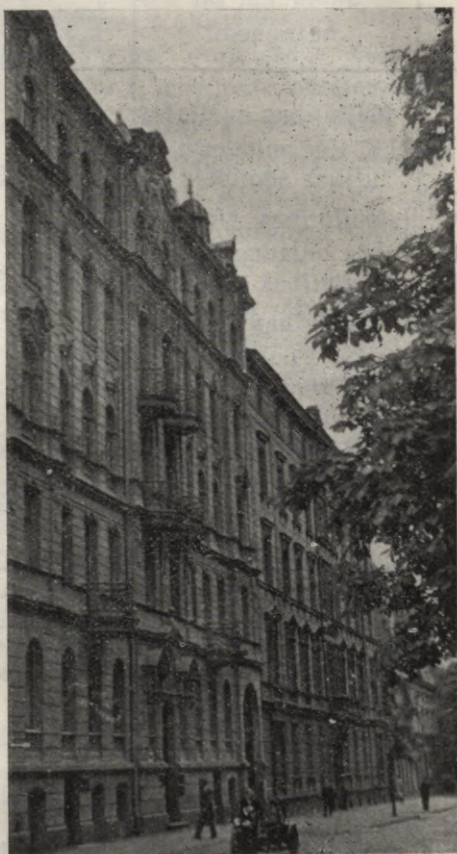
LLK nams Rīgā, Baznīcas ielā 4-a, kur ziemas mēnešos darbojas Kaucmindes mājturības seminārs
