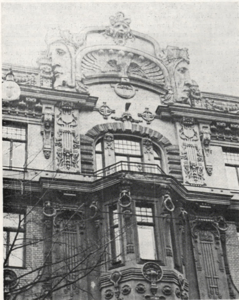
268. Īres nama fasādes daļa Elizabetes ielā 10b, arch. M. Eizenšteins, 1971. g. uzņēmums
