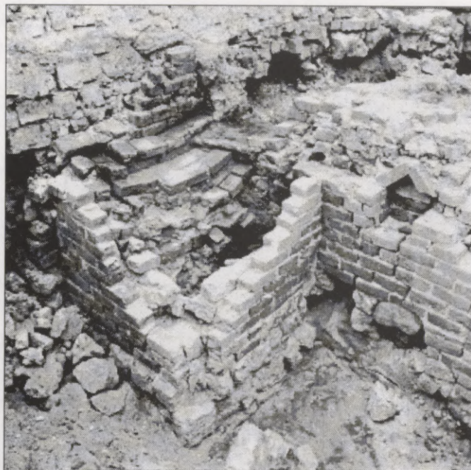
13. att. Vecdoles pils. Krāsns III laukuma celtnē ar 6 reizes atjaunotu ķieģeļu klonu. Pagraba sienā – niša apgaismes ķermeņa novietošanai.
