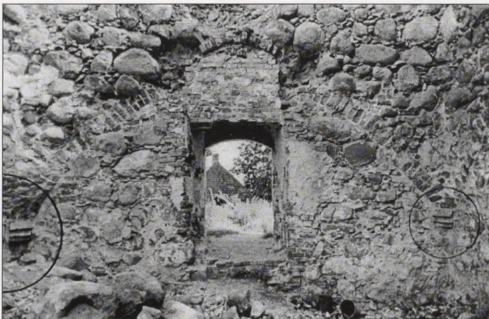
6. att. Kapelas velves pieres loks un konsoles (V. Šaicāna foto 1968. g.)
