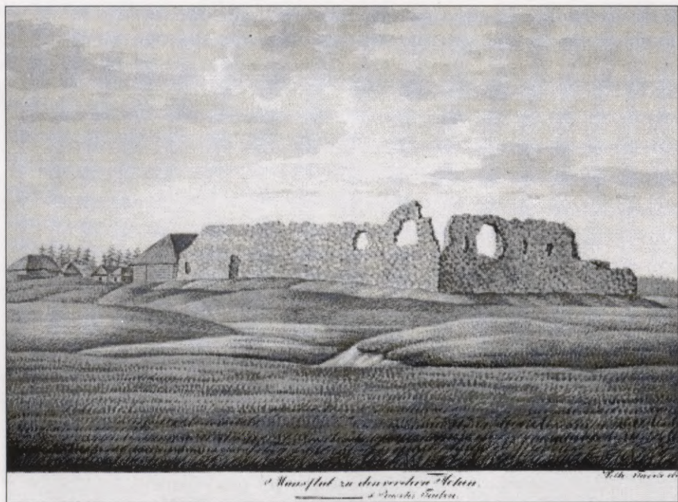
2. att. Skats uz Piebalgas pilsdrupām no rietumiem (V. Tuša akvarelis t.s. Pauluči albumā, ap 1827. g.)
