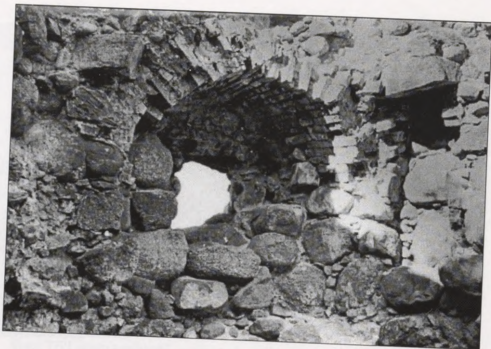
8. att. Rozbeķu pils torņa 2. stāva šaujammkamera no iekštelpas puses 1997. gadā. Skats no ziemeļiem
