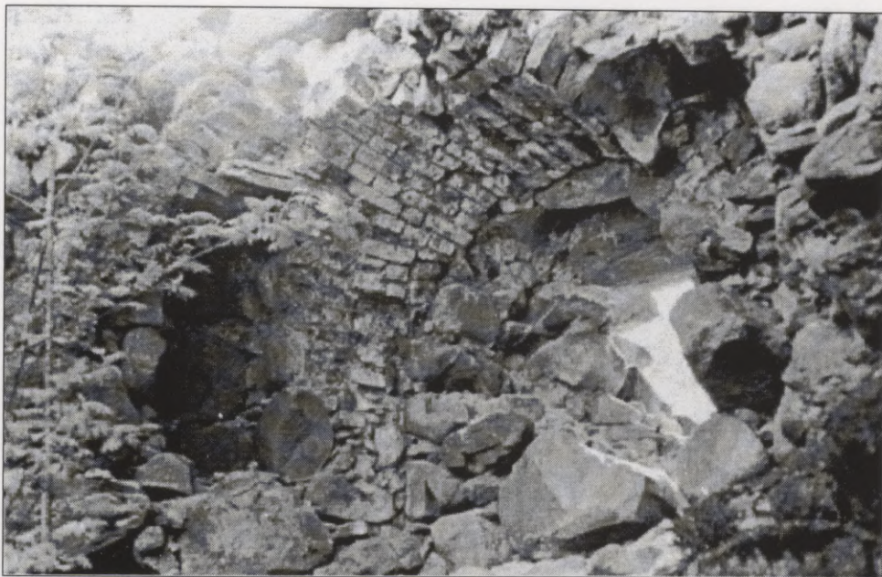
7. att. Rozbeķu pils torņa 2. stāva šaujamlūkās no iekštelpas puses 1997. gadā. Skats no dienvidiem
